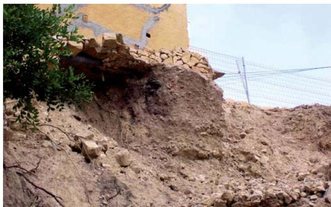
Figura 1.D. Cimentación en voladizo de una vivienda en el deslizamiento de la figura 1.C.
