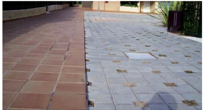
Figura 3.B. Hundimiento del firme del vial de una urbanización, donde no se realizó una compactación adecuada. Se puede apreciar el colapso en dos zonas. En una zona más anaranjada (centro de la figura) y en el encuentro del pavimento con el muro de las viviendas (izquierda), donde se aprecia la sinuosidad del mismo.
