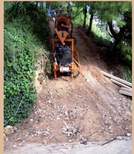
Figuras 18.A y 18.B. Subida de rampa "acondicionada" de 42°, con ayuda de cabrestante manual para realizar un sondeo geotécnico de 28 metros en un talud de patología de la figura 1.A.
