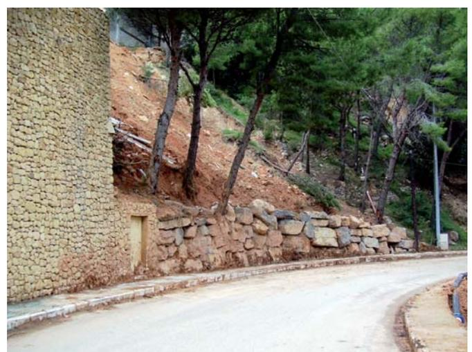
Figura 1.B. Vista lateral del mismo deslizamiento en el que se puede apreciar cómo en la zona del talud donde no se realizó la escollera no deslizó (derecha).
