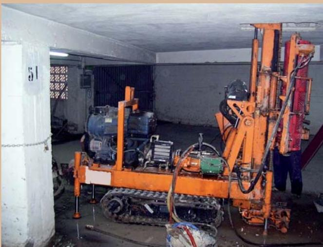
Figura 21. Máquina de sondeos trabajando en un sótano bajo forjado de 2,20 metros. Se tuvieron que romper unos 15 centímetros de bovedilla hasta llegar a la capa de compresión y poder emplazar la torre de perforación.
