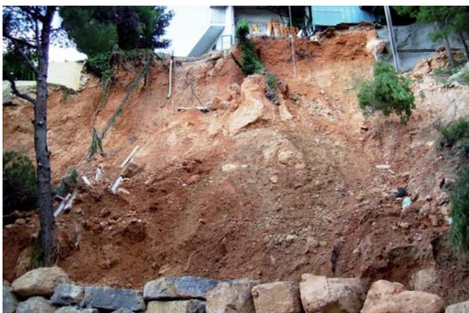
Figura 1.A. Deslizamiento de un talud limo-arcilloso en el que, en su parte superior, se ubica una vivienda cuya cimentación queda en voladizo, y en su parte inferior se emplazó un muro de escollera para contener el talud y realizar la carretera, lo que produjo un cambio en las condiciones del mismo y el consiguiente deslizamiento al superar la pendiente del talud, descabezado el ángulo crítico.
