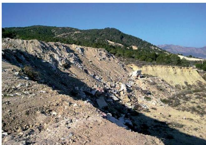
Figura 2.A. Talud donde se tiene previsto emplazar urbanización en la que se han vertido rellenos antrópicos no controlados.
