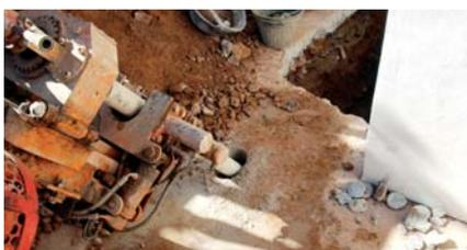
Figuras 4.C y 4.D. Perforación de solera de la vivienda, atravesando materiales con un ángulo de unos 30° y batería simple atravesando materiales en la calicata realizada.
