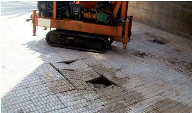
Figura 3.A. Máquina de sondeos desplazándose por un vial de una urbanización, donde se puede apreciar un colapso o hundimiento del firme por un lavado de finos.
