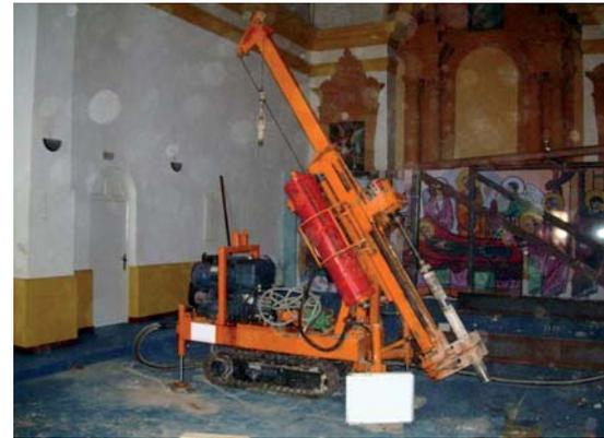
Figura 6.A. Sondeo inclinado en una iglesia para obtener el dato de la anchura de zapata, procediendo a la perforación lateral de la misma.
