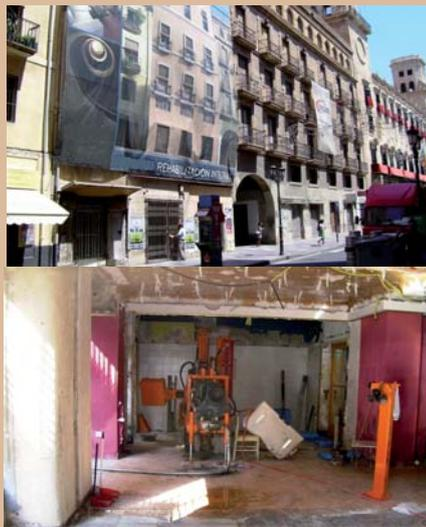
Figuras 13.A y 13.B. Edificio a rehabilitar con entrada de 2,60 metros de altura y 2,50 metros de anchura. Máquina realizando sondeos bajo forjado de 2,45 metros, con extensión de la torre de perforación a la derecha.
