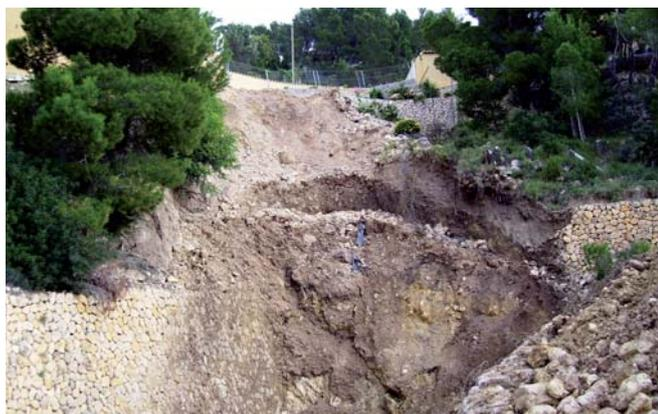
Figura 1.C. Deslizamiento de un talud, provocado por fuertes lluvias, en el que se aprecia rotura en cuña, con vivienda emplazada en el margen superior izquierdo.
