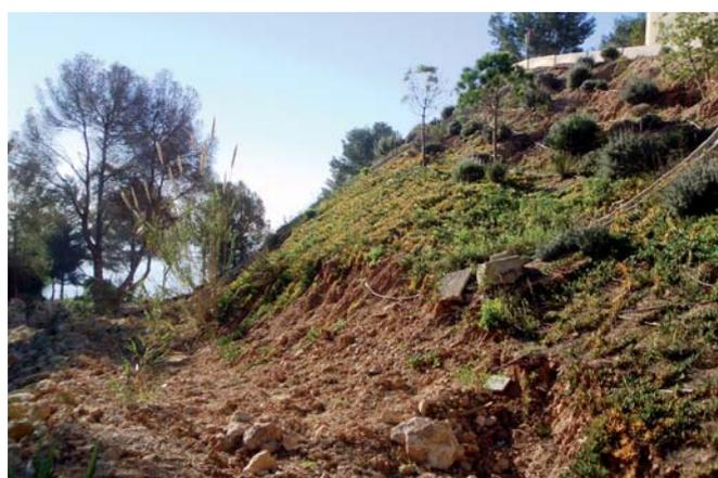
Figura 1.F. Descabezamiento de un talud (zona sin vegetación) para la realización de un encauzamiento, que produjeron las anomalías en el vial de la figura 1.E.
