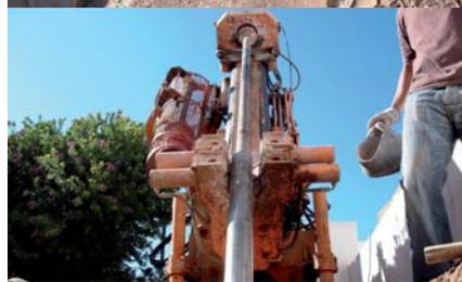
reconocer los materiales que forman parte del subsuelo, y, en segundo lugar, se realizó un sondeo inclinado para obtener anchura de la cimentación. En este último caso se trataría de perforar inicialmente en un lateral de la zapata y atravesarla completamente hasta salir por el otro lateral de la misma, sabiendo de esta manera, y mediante la ley de los ángulos, la anchura exacta de la zapata.
