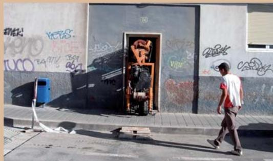
Figuras 14.A y 14.B. Edificio que presenta una patología y precisa de un estudio geotécnico para realizar un ascensor que presenta limitación tanto en anchura como altura. Máquina entrando en dicho zaguán con entrada de 0,73 metros.
