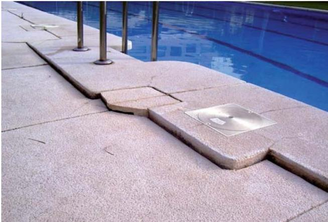
Figura 3.C. Colapso de 7-8 centímetros del bordillo de una piscina, provocado por un lavado de finos producido por el agua proveniente del riego del jardín o por la fuga del vaso de la piscina.
