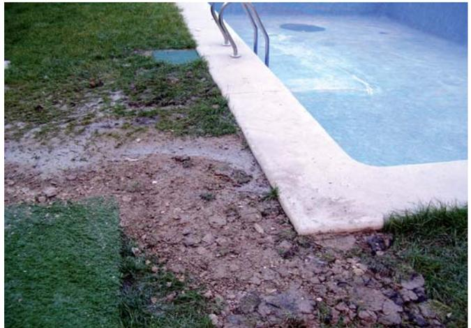
Figura 3.D. Reparación de zona conflictiva junto a vaso de la piscina, en el cual se detectan grietas transversales y longitudinales.
