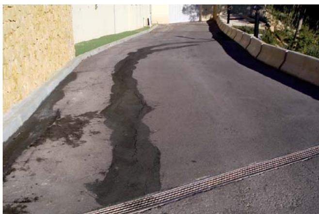
Figura 1.E. Grietas en vial de urbanización junto a talud que deslizó por descabezamiento de la base del mismo.
