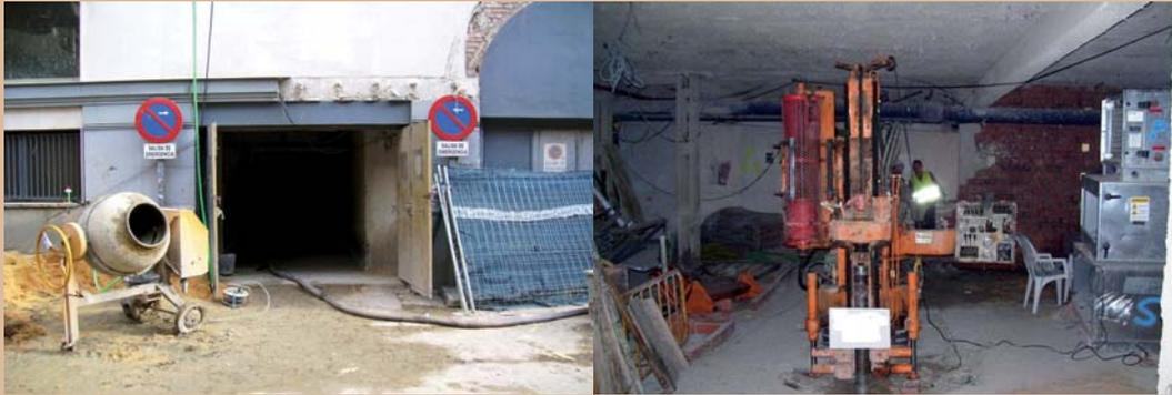
Figuras 12.A y 12.B. Sondeo en el sótano de un hotel, en condiciones extremas, donde se aprecia una manguera de extracción de humos de 3", usada en minería.
