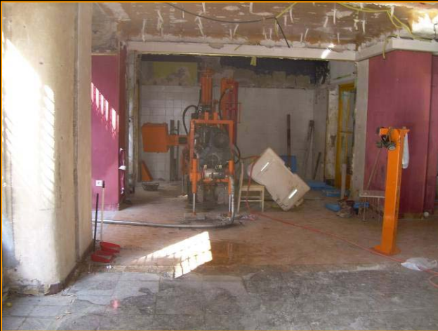
Máquina de sondeos adaptada para microgeotecnia
