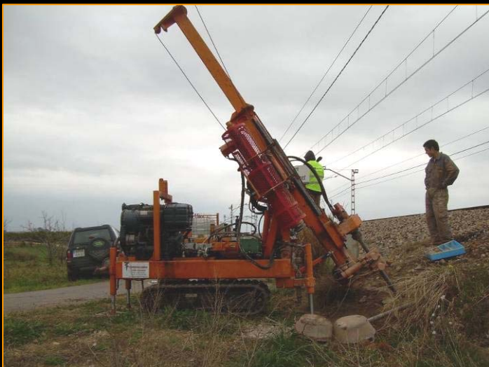
Máquina realizando sondeos inclinados para Ingeniería y Geotecnia con la extensión de torre de perforación
