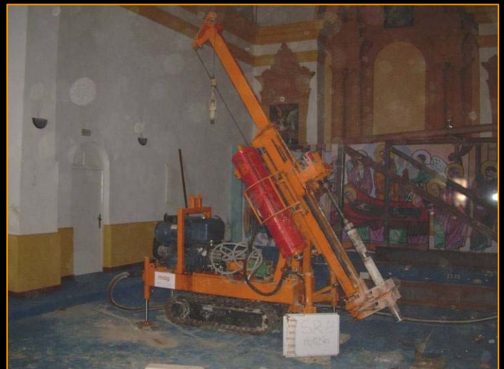
Máquina realizando sondeos inclinados para Ingeniería y Geotecnia con la extensión de torre de perforación
