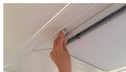
Fig. 9 Colocar estructura cerrando los pasadores de sujeción.
