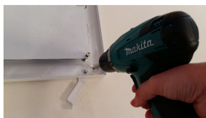
Fig.7 Fijar al techo (habiendo utilizado tacos y/o balancines según material de fijación). Yeso, piedra, madera, escayola, etc.
