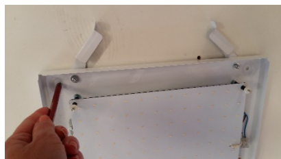
Fig.5 Marcar puntos de sujeción.
