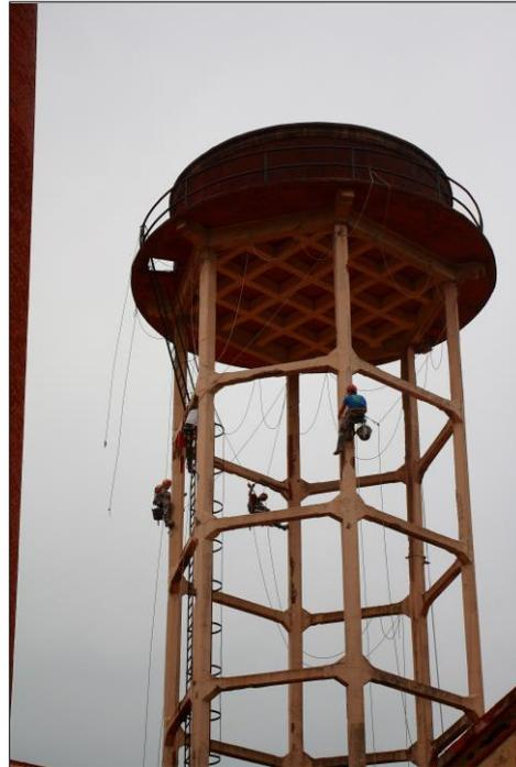
Se denominan técnicas de acceso y de posicionamiento mediante cuerdas (trabajos verticales) a las técnicas para trabajar en altura que se basan en la utilización de cuerdas, anclajes y aparatos o elementos de progresión, junto con sistemas anticaídas y otros accesorios específicos, para acceder y realizar un determinado trabajo a cierta altura.
