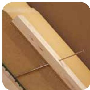
1-3 En la tarima de la cubierta se coloca una pantalla pro clima DA, sobre ella una capa de GUTEX Thermosafe-homogen. Con el GUTEX-Multiplex-top impermeable se crea un bajo teja a prueba de viento y marea.
