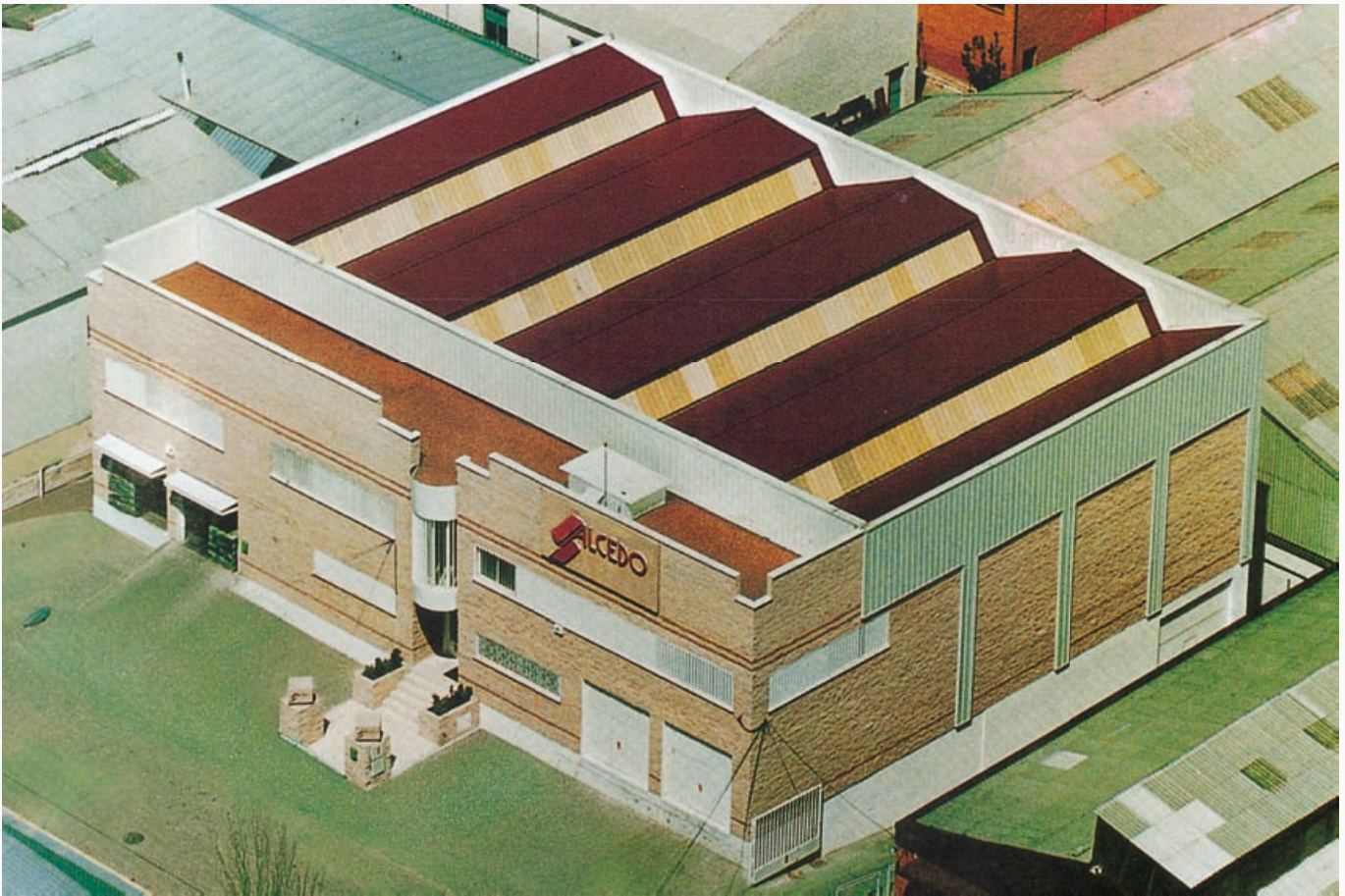
Vista Naves Centrales C/ Mercurio Nº 12 Pol. Ind. San José de Valderas MADRID
