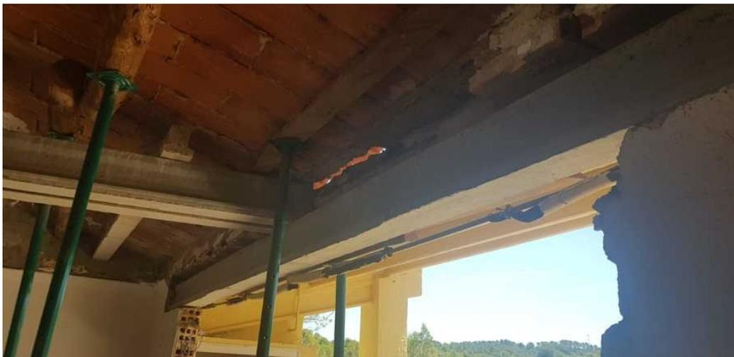
Se colocaron vigas transversales y longitudinales de refuerzo.
