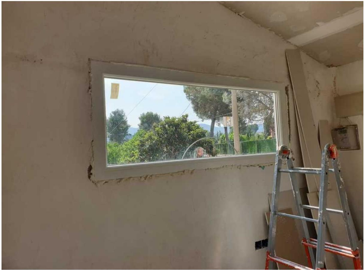
En este caso se propuso un vidrio fijo, en la ventana de PVC doble junta, ya que la ventilación de la sala esta garantizada con el ventanal principal.
