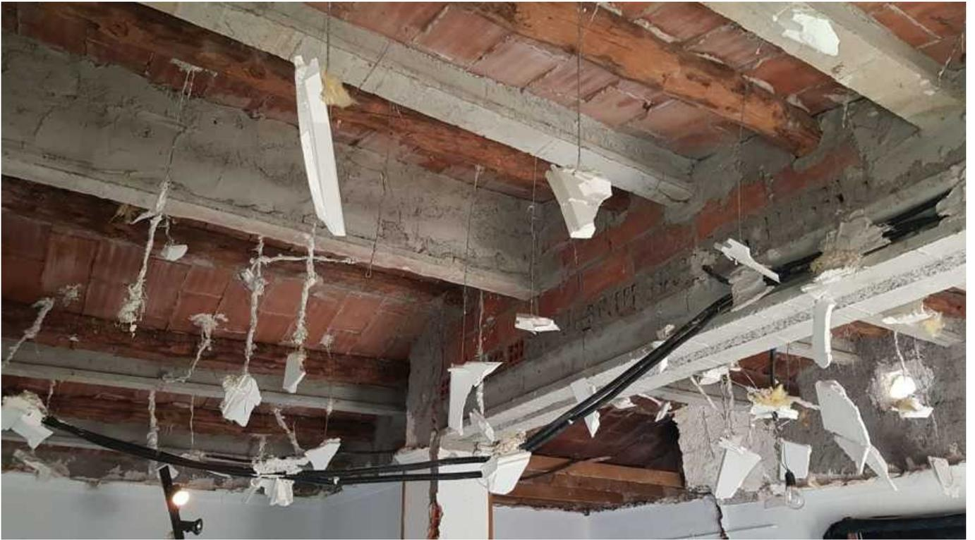
Nos encontramos con unos techos en muy mal estado, que hubo que reforzar con vigas en varios puntos. Se renovó toda la instalación eléctrica y de aguas, ya que tenía fugas en varios puntos.
