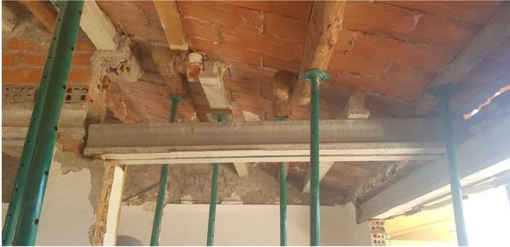
Los Trabajos previos son lentos y a veces parece que no avanzan, y suelen prolongarse más de lo previsto sin un seguimiento preciso. Aquí se puede observar el estado de los techos antes de la reforma, durante la colocación de las vigas adicionales de refuerzo.
