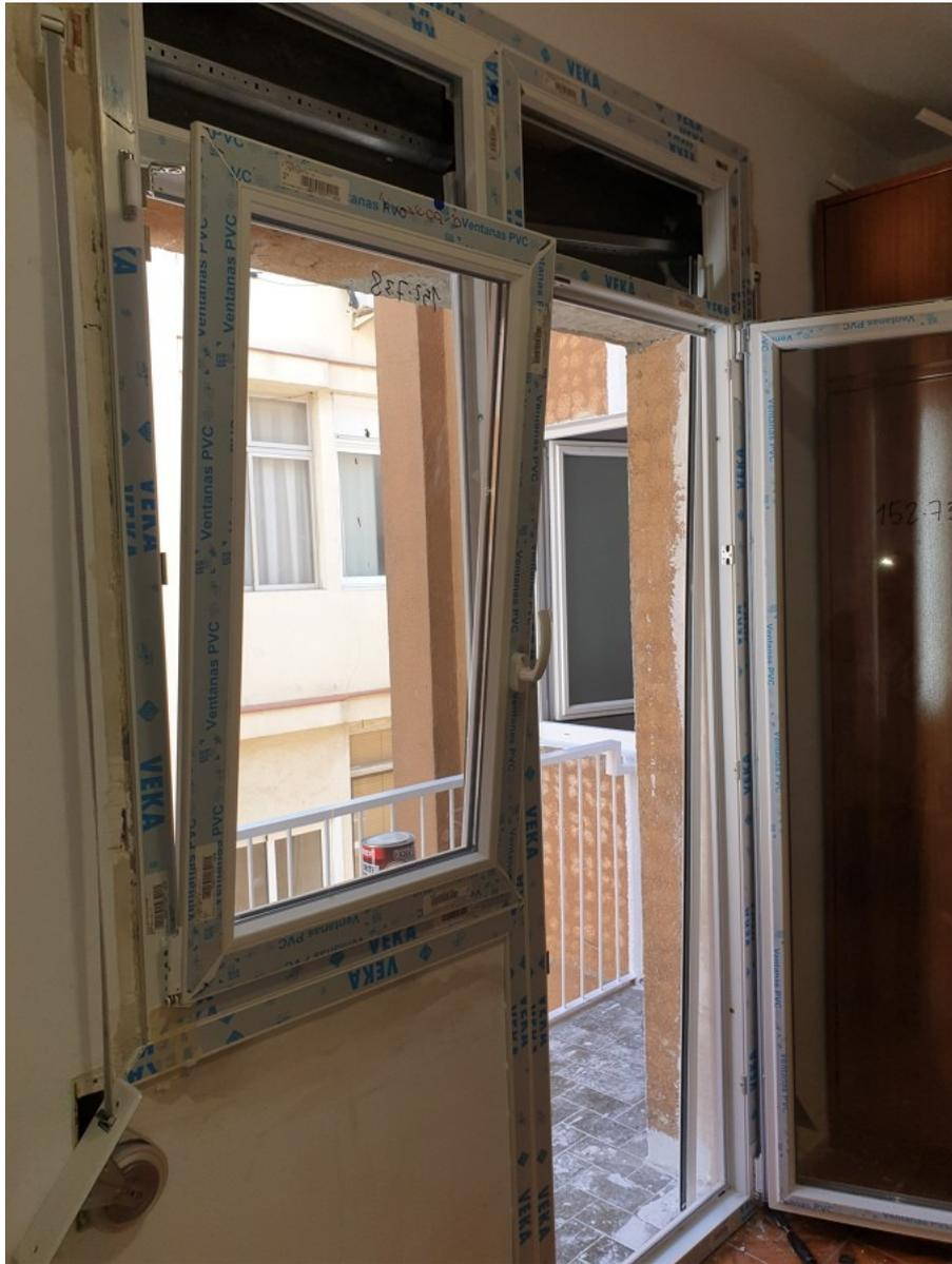
Se cambió la ventana del salón por una ventana bandera de PVC, de sistema oscilobatiente en color blanco, con persianas. Este sistema a porta gran comodidad para ventilar a diario, y el PVC de la marca VEKA, de doble junta, con cristal doble cámara bajo emisivo, asegura el máximo aislamiento a la estancia.
