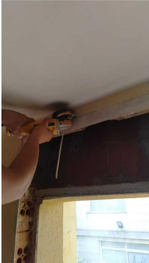
En esta ocasión, al arrancar las ventanas antiguas nos encontramos con la necesidad de cortar algo el zuncho, para adaptar la apertura resultante a la medida de la ventana. Esto puede ocurrir, según la forma en que la ventana antigua estaba insertada en la pared, ya que al tomar las medidas de las ventanas procuramos hacerlas lo mas amplias posibles para permitir la màxima entrada de luz.
