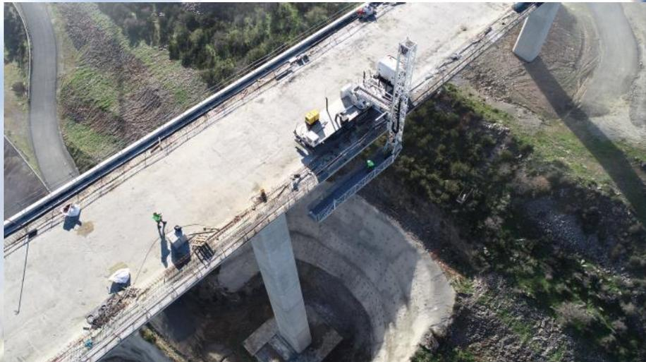
**TRABAJOS DE DESTENSION DE LOS PERNOS DE SUJECCION DE PLATAFORMA EN LA CABECERA DE LAS PILAS MEDIANTE GATO DE PISTON HUECO.**
