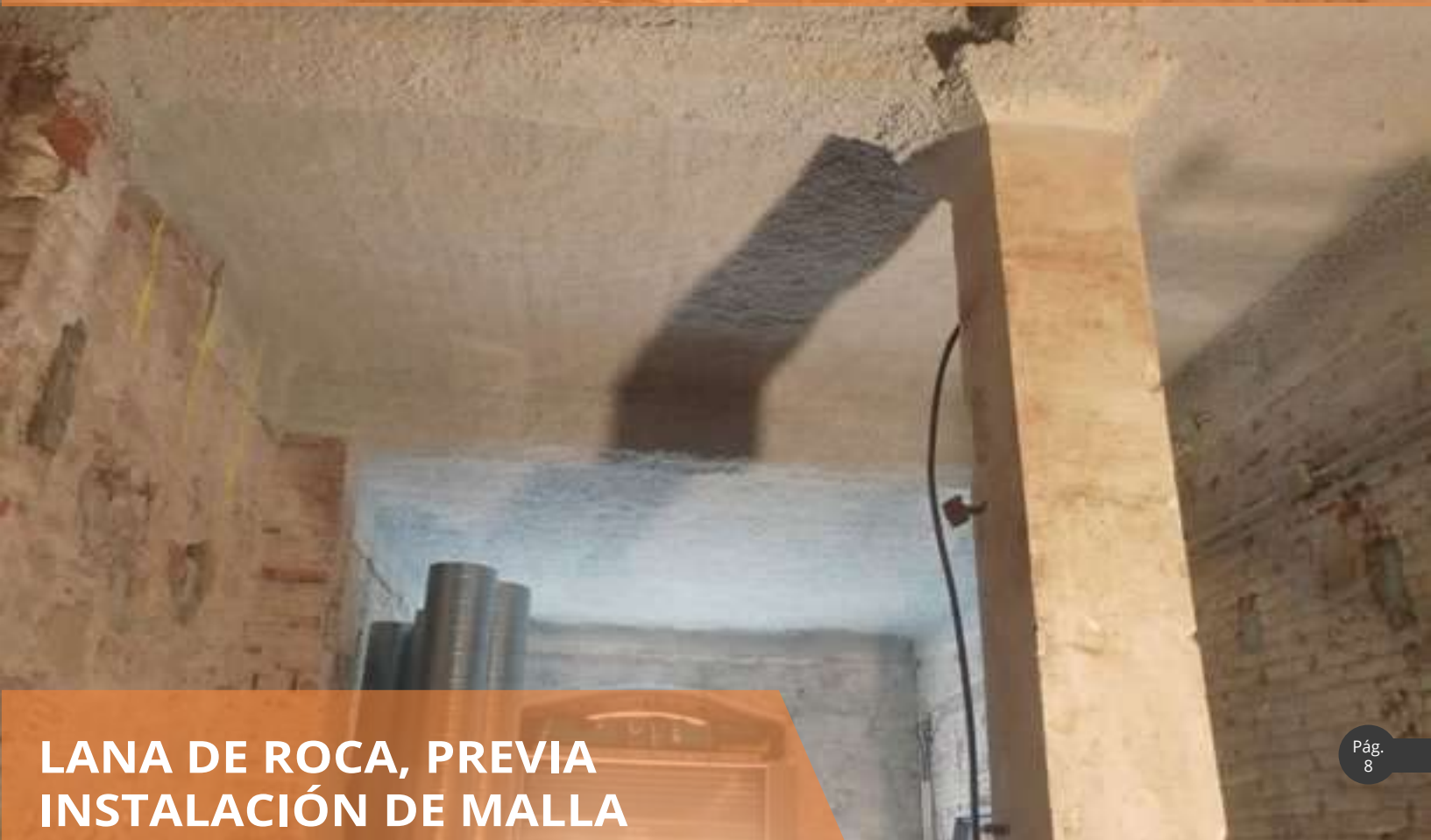
LANA DE ROCA, PREVIA INSTALACIÓN DE MALLA
