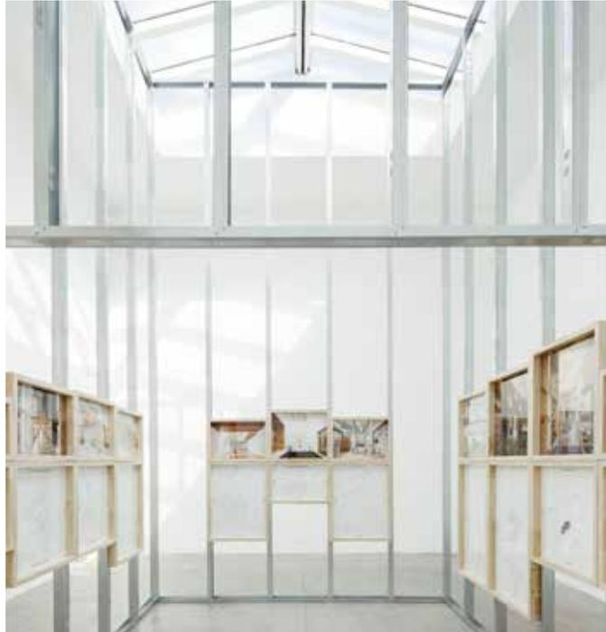
En cuanto a los espesores, éstos tienen un valor nominal de 0,6 mm. (+/- 0,05) para los elementos portantes verticales (montantes y maestras) y un valor nominal de 0,55 mm. (+/- 0,05) para los elementos horizontales (canales y angulares).
