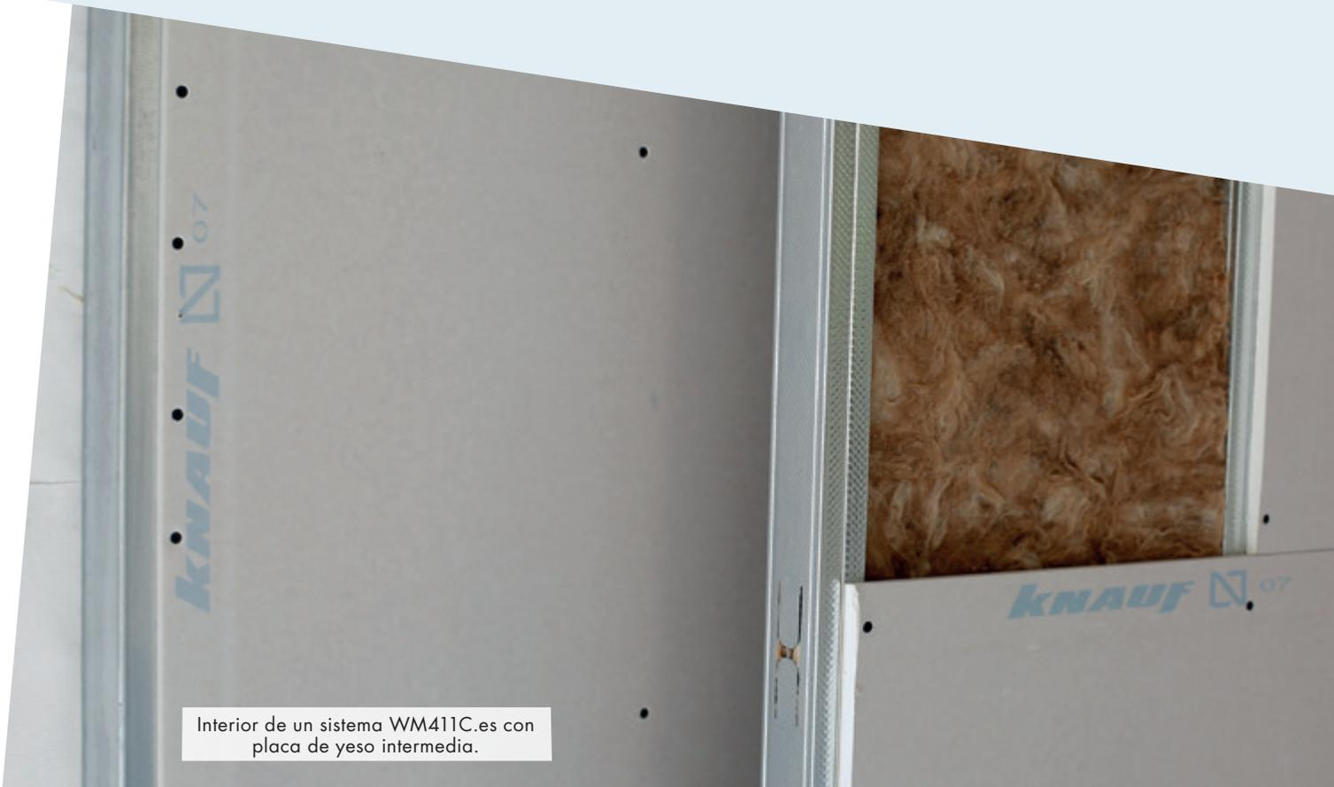
Los montantes de AQUAPANEL® difieren de los montantes de tabique interior en varios aspectos. Principalmente tienen un mayor espesor, un mayor galvanizado y una mayor dimensión de "ala". **El ala de los perfiles AQUAPANEL® es siempre de 50 mm, mayor que los perfiles de interior.** Esta es una característica que nos ayudará a diferenciar a simple vista los perfiles de interior y de exterior.
