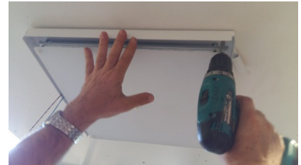
Fig.5 Fijar al techo (habiendo utilizado tacos y/o balancines según el material de fijación, Hormigón, pladur, escayola..)
