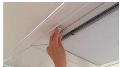
Fig. 7 Colocar estructura cerrando Los pasadores de sujeción.
