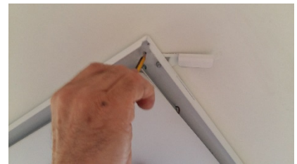
Fig.3 Marcar los puntos de sujeción.
