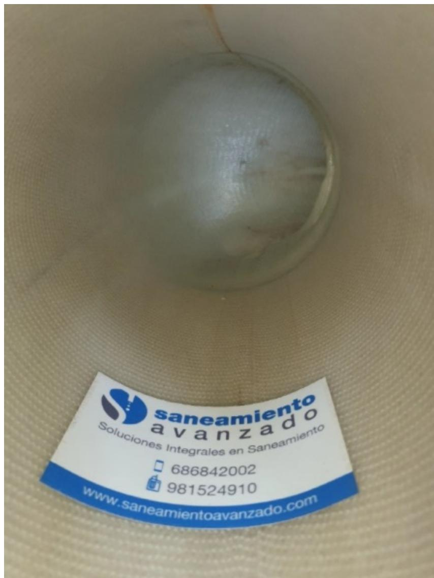
Imagen del acabado final interior del sistema de rehabilitación de tuberías con manga continua.
