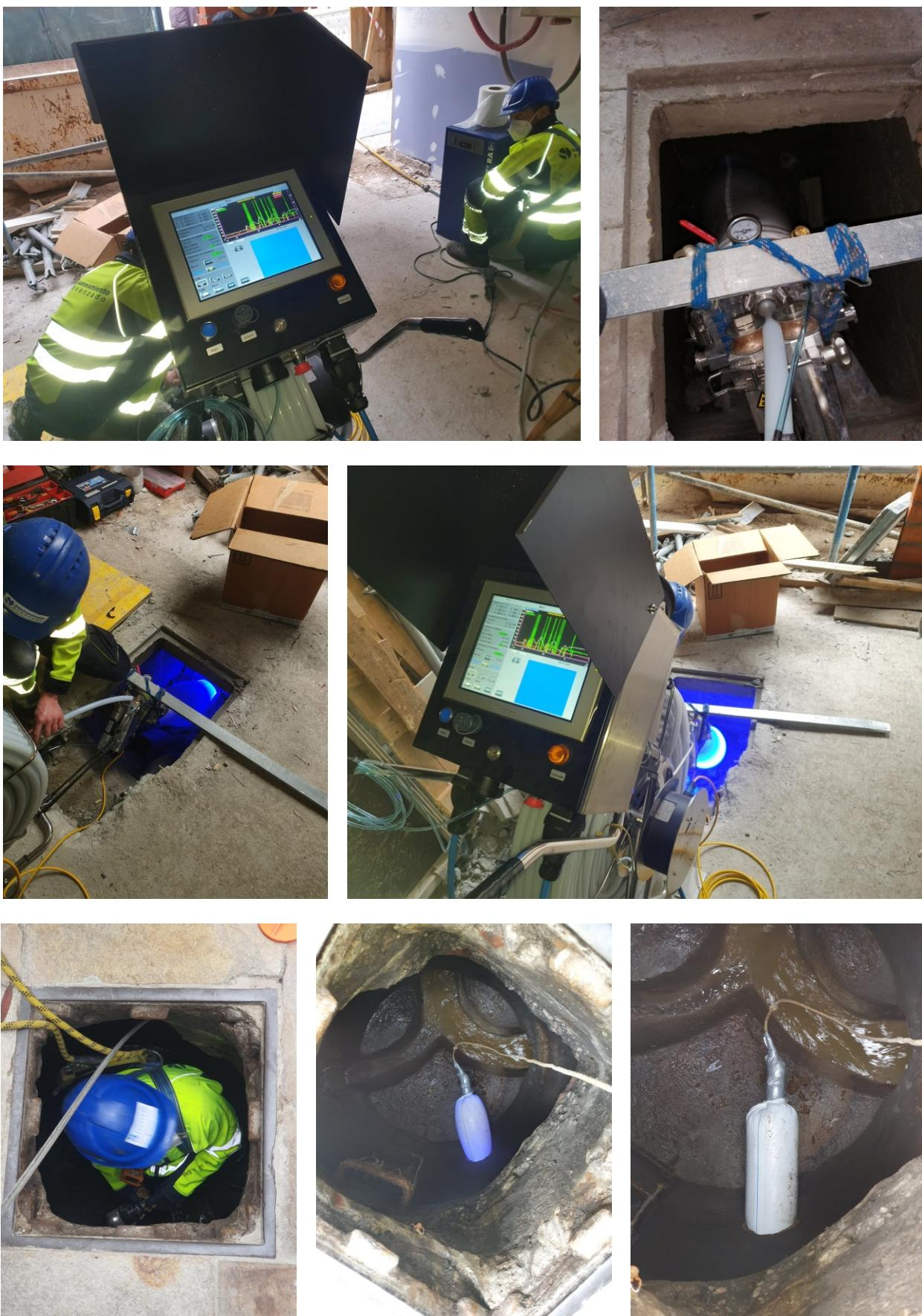
Una vez ejecutado la reparación con el sistema de manga continua, se procede a realizar el fresado de la conducción en el punto de conexión con la acometida directa por medio del robot fresador.
