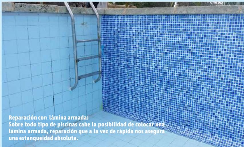
Reparación con lámina armada: Sobre todo tipo de piscinas cabe la posibilidad de colocar una lámina armada, reparación que a la vez de rápida nos asegura una estanqueidad absoluta.
