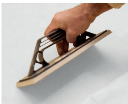
**4.** Presionar fuerte la lámina **DYSO** sobre el soporte con ayuda de la llana, asegurándonos de eliminar con la todas las posibles bolsas de aire que se hayan generado.
