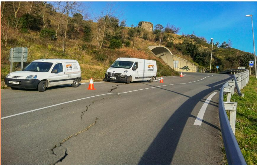
Grietas de tracción y ondulación de vial por deslizamiento en Mutriku (Guipuzcoa)
