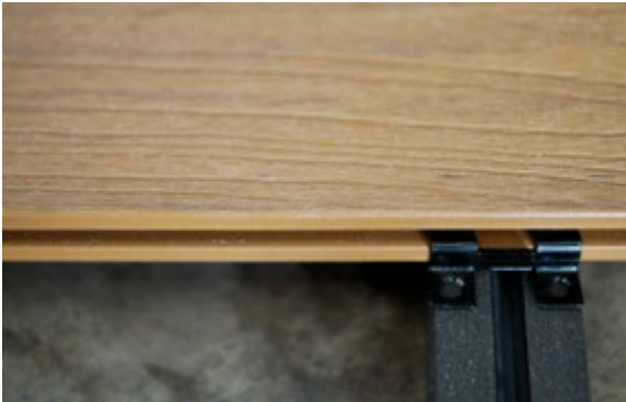
Detalle sujeción de lama con clip
