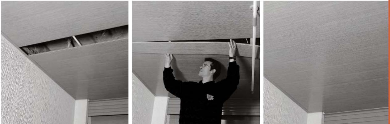
Para hacer una lama registrable, antes de montar, hay que cortar con cuchilla por los dos puntos indicados.
