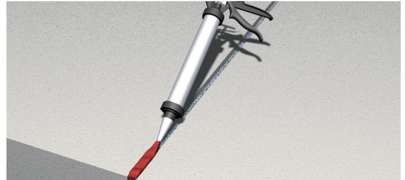
debería de ser 2:1 en una mínima profundidad de 10mm.
