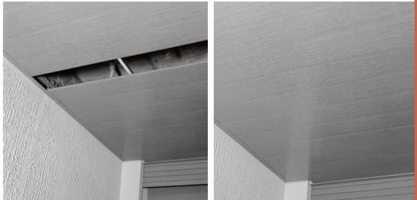
Para hacer una lama registrable, antes de montar, hay que cortar con cuchilla por los dos puntos indicados.
