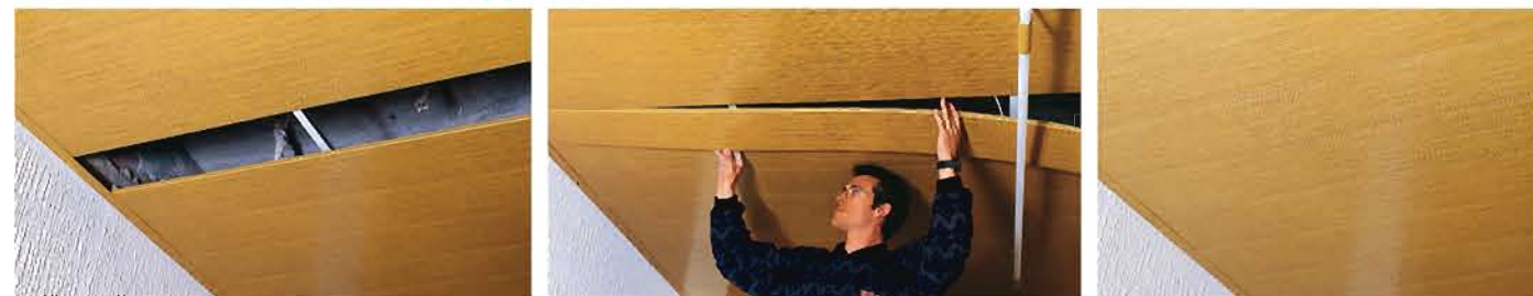
INSTALACIÓN DE FALSO TECHO DE P.V.C. SOBRE PERFIL PRIMARIO CON LAMA REGISTRABLE
