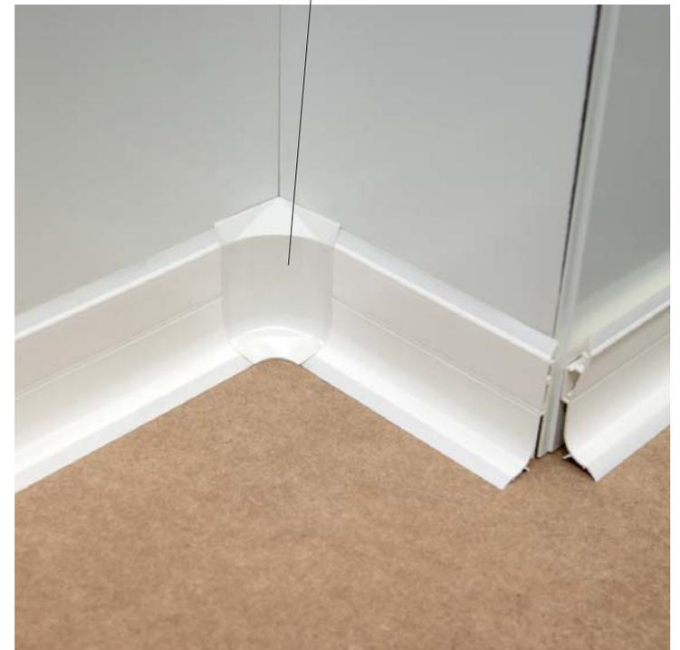
En la parte de arriba se atornilla la pieza sobre la que clipará la Junta Rinconera de 2 o de 3 direcciones.
