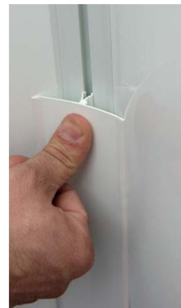
Y arriba colocaremos la Junta Rinconera de 3 direcciones.
