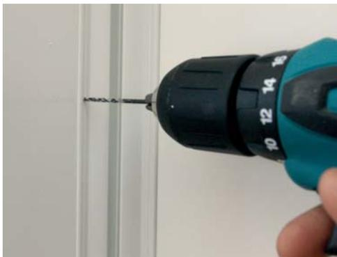
Si preferimos colocar la rinconera vertical, atornillaremos sobre el panel la pieza en la que clipa, y a continuación la Rinconera.
