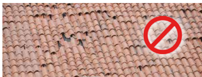
Posa delle tegole senza i ganci per l'ancoraggio
