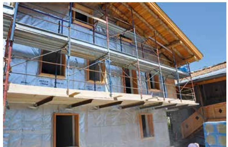
Grazie alla sua composizione USB Reflex Plus è una membrana traspirante con la superficie altamente riflettente; per questo motivo il prodotto che deve essere utilizzato per sigillare questo tipo di membrana è USB Tape Reflex, un nastro adesivo acrilico con il supporto in alluminio, a sua volta riflettente come tutto il resto della superficie.
