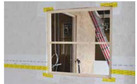
**USB Micro 100/20** è uno schermo freno al vapore in polipropilene a 2 strati termosaldato e stabilizzato ai raggi UV. Per la sua adattabilità, semitrasparenza ed il valore Sd di 20 metri è il prodotto ideale per l'applicazione a rivestimento interno del coibente posato nell'intradosso delle strutture in legno, siano esse a copertura o a parete. USB Micro 100/20 garantisce una perfetta tenuta all'aria e controlla il passaggio del vapore acqueo lasciandone filtrare solo una minima parte.
