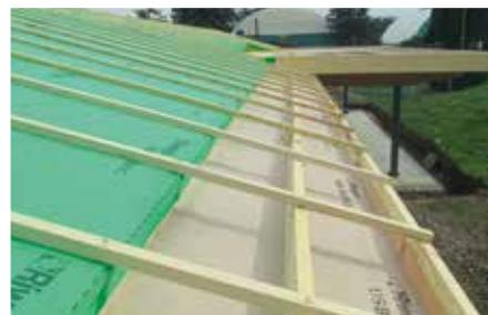
**USB Micro** è uno schermo freno al vapore impermeabile all'acqua ed all'aria a tre strati; gli strati superiore ed inferiore sono rappresentati da tessuti non tessuti in polipropilene che vanno a proteggere il film centrale a bassa traspirazione in polipropilene. I tre strati vengono accoppiati e saldati tra loro tramite termosaldatura.
