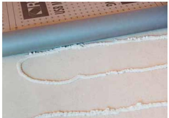
USB Micro Strong può essere posato direttamente sul tetto in laterocemento incollandolo alla caldana tramite la schiuma adesiva USB GLUE applicata in strisce di spessore di 2 cm ad una distanza di circa 25 cm l'una dall'altra (si può posare a "serpentina"). Lasciare all'aria da 1 a 3 minuti e poi stendere lo schermo al vapore. Dopo 8/10 minuti (a 20°C e 65% UR) sarà incollato e calpestabile; per ogni rotolo di schermo freno al vapore da 75 mq sono consigliabili 3 bombole di USB GLUE.
