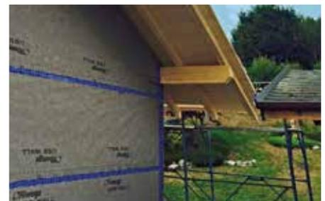
**USB WALL 120** e **USB WALL 100** sono membrane termosaldate a tre strati, ad alta traspirazione di bassa grammatura (120 e 100 g/m<sup>2</sup>). Con le loro caratteristiche sono i prodotti specifici per garantire impermeabilità all'acqua e al vento nel rivestimento esterno di pareti ventilate. Esse si collocano direttamente sul cappotto esterno nel caso di facciate ventilate con rivestimento esterno continuo.
