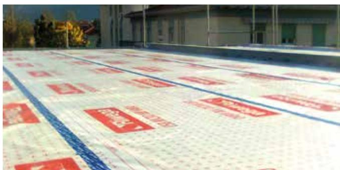
Per garantire una totale garanzia di sigillatura all'aria dello schermo freno al vapore USB Micro 100 VARIO, viene proposto il nastro adesivo acrilico, retinato, con supporto in polietilene USB Tape 1 PE. Questo tipo di nastro risulta particolarmente efficace in svariati punti di sigillatura, come la sovrapposizione orizzontale, le giunzioni verticali oppure la giunzione tra schermo e svariati componenti edili (murature, legno, camini, sfiati in plastica o metallo, ecc.).
