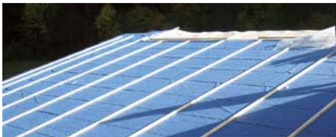
**USB Micro 230/20**, grazie alla colonna d'acqua di oltre 9 m, può essere usato in sostituzione delle guaine bituminose come ultimo strato impermeabilizzante sottotegola nei pacchetti che prevedono il secondo tavolato con la ventilazione tra il pacchetto coibente e il tavolato stesso.
