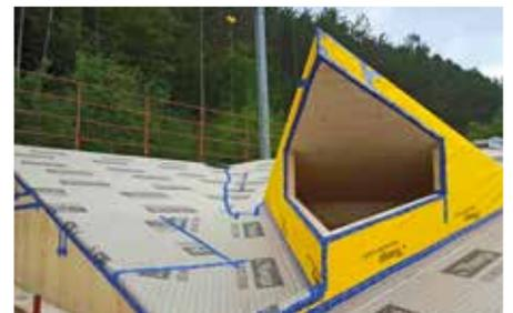
**USB Micro Light** è uno schermo freno al vapore impermeabile all'acqua ed all'aria a tre strati; gli strati superiore ed inferiore sono rappresentati da tessuti non tessuti in polipropilene a protezione del film a bassa traspirazione in PE. I tre strati vengono accoppiati e saldati tra loro tramite termosaldatura.
