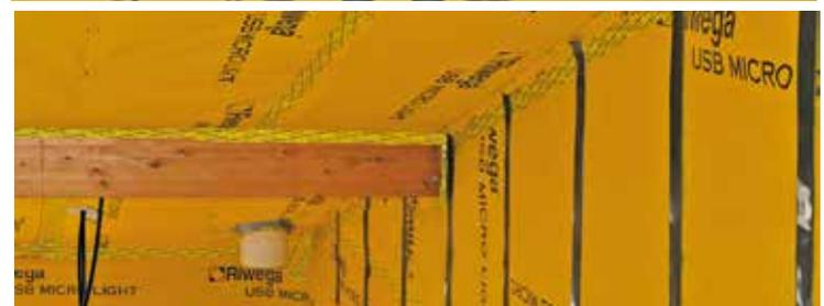
USB Micro Light quando viene posato come freno al vapore all'interno delle strutture viene poi rivestito da pannelli in cartongesso o fibrogesso, e per questo motivo viene forato dalle viti di fissaggio dei pannelli o delle strutture di supporto. Per evitare il passaggio di vapore attraverso questi fori, e per garantire una perfetta tenuta all'aria, è necessario utilizzare la guarnizione USB TIP KONT nei punti di fissaggio dei pannelli.
