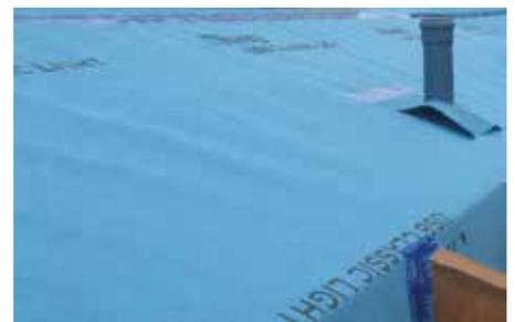
**USB Classic Light** è una membrana impermeabile ad alta traspirazione a tre strati; gli strati superiore ed inferiore sono rappresentati da tessuti non tessuti in polipropilene che vanno a proteggere il film centrale in polipropilene UV 10 PP Plus. I tre strati vengono accoppiati e saldati tra loro tramite termosaldatura.
