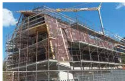
**USB Elefant** è una membrana impermeabile ad alta traspirazione a tre strati; gli strati superiore ed inferiore sono rappresentati da tessuti non tessuti in polipropilene di alta grammatura che vanno a proteggere il film centrale in polipropilene UV 10 PP Plus. I tre strati vengono accoppiati e saldati tra loro tramite termosaldatura.
