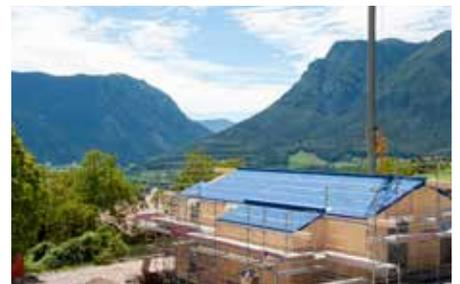
**USB Flamaxx** è caratterizzata dalla scelta dei materiali non infiammabili e dalla particolare cura dei dettagli nelle varie fasi di produzione, requisiti fondamentali che fanno della USB Flamaxx la prima membrana ritardante alla fiamma, altamente traspirante e resistente allo strappo.
