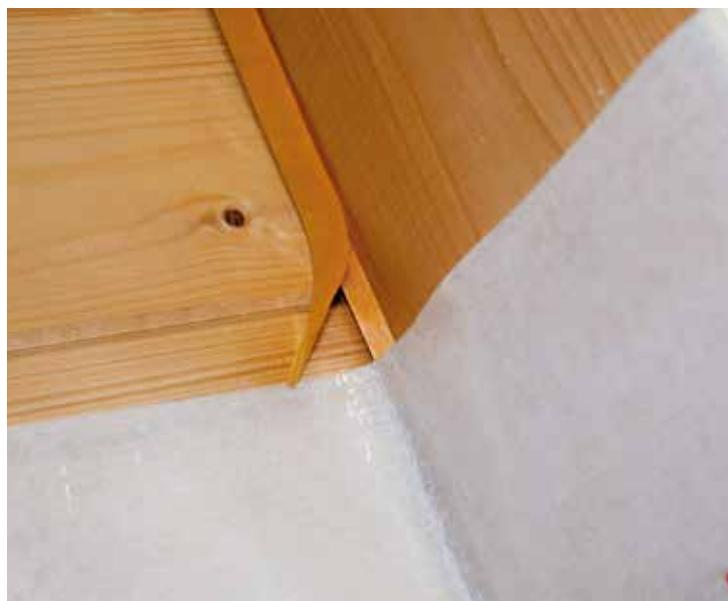
Per garantire l'ancoraggio alla struttura senza forare lo schermo e la totale ermeticità all'aria del sistema, si può utilizzare USB Tape 2 AC BOLD. Una massa adesiva acrilica con retina di rinforzo in poliestere ad alta tenuta adesiva, viscoelastica e di spessore maggiorato, appositamente studiata per l'incollaggio e la sigillatura degli schermi freno o barriera al vapore su qualsiasi tipo di supporto edile (legno, murature, intonaci, cemento, metallo).
