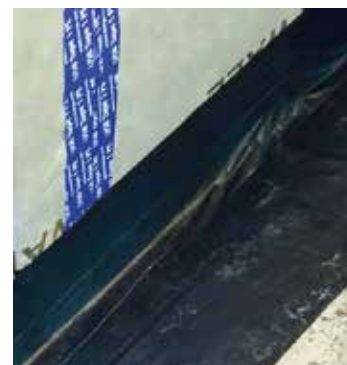
Impermeabilizzazione della parete X-Lam a terra.
