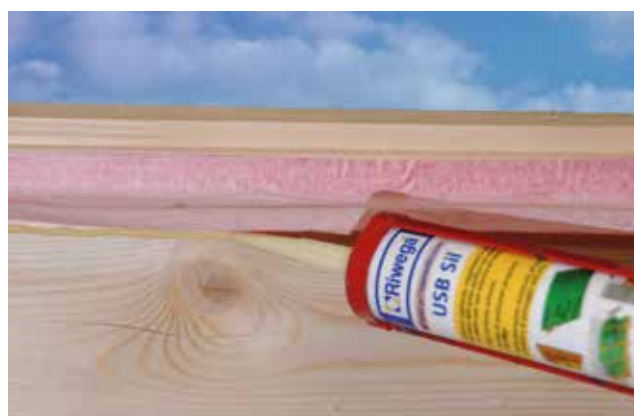
Incollaggio del nastro interno FDB INT AC su legno.
