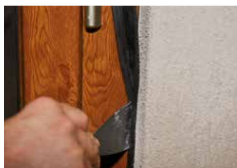
Sigillatura tra finestra e muro
