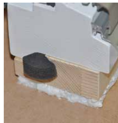
Sigillatura all'aria tra serramento e falsotelaio.
