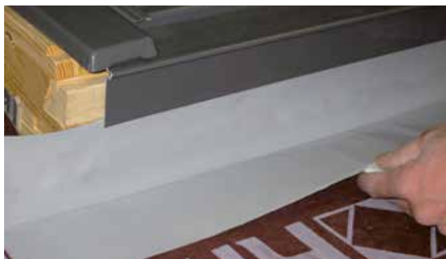
2. Posa del nastro USB Coll 150 X sul lato basso della finestra
