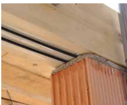
Sigillatura dell'appoggio della trave di banchina
