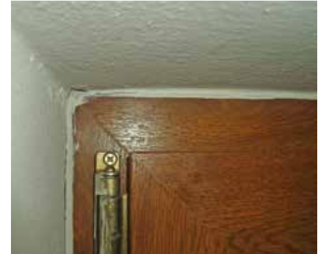
Distacco del silicone dall'intonaco
