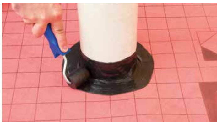
5. Pressione tramite rullino sulla membrana USB Riwega.
