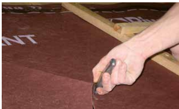
1. Taglio dello schermo traspirante USB Riwega
