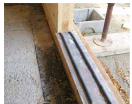
Sigillatura dell'appoggio di una parete in legno
