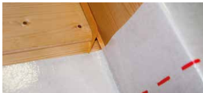
Incollaggio di schermo freno al vapore su travi in legno
