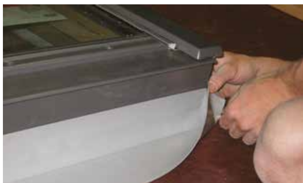
3. Rimozione del liner sottostante prima nella parte superiore e poi in quella inferiore
