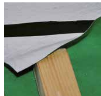
Sigillatura tra SMT e muratura
