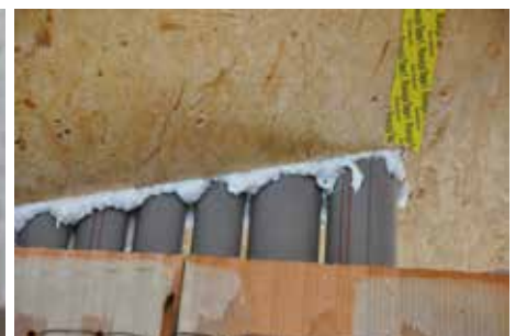
Riempimento di cavità, fughe ed interstizi tra le strutture edili
