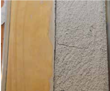
Fessura tra intonaco e falsotelaio
