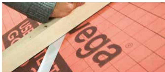
Posa di USB Tip KONT DUO biadesivo con rimozione del liner
