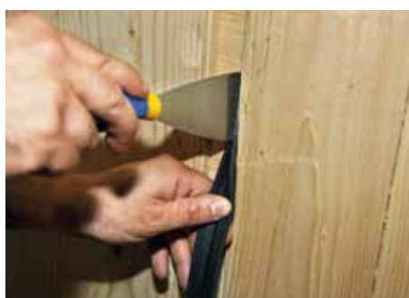
Sigillatura tra pareti in legno
