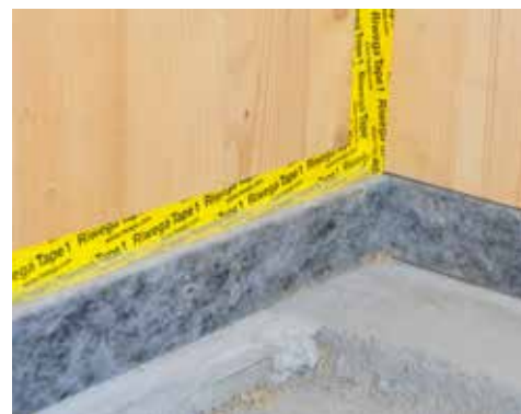
Impermeabilizzazione della trave di banchina a terra
