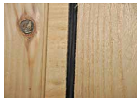
Sigillatura tra pareti in legno
