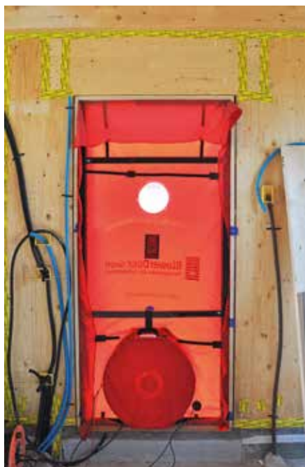
Ventola per BlowerDoor test controllata da un computer
