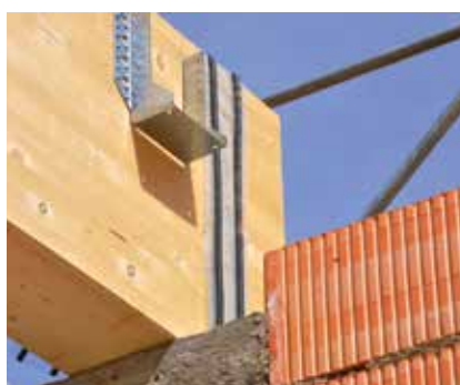
Sigillatura dell'appoggio di una singola trave
