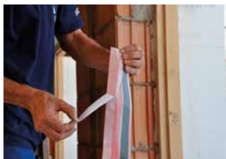
Falsotelaio a filo interno su muratura con intonaco
