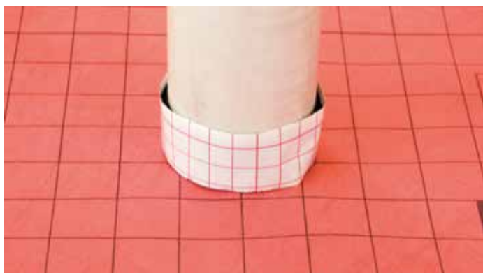
1. Incollaggio della metà di USB Coll Flexi sul corpo emergente.
