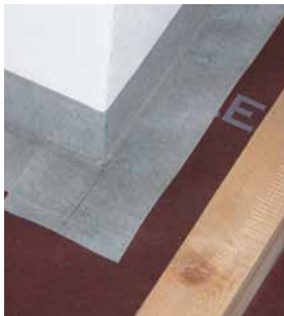
Sigillatura di un camino con AIR Coll 150 X con possibilità di una successiva intonacatura
