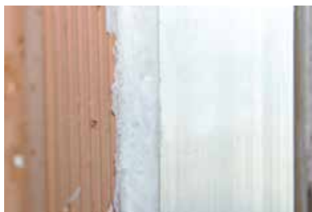
Riempimento tra muratura e falsotelaio
