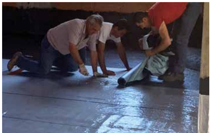
Incollaggio della barriera al radon USB Coll Radon BIT
