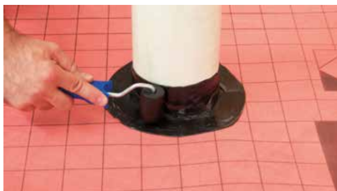
6. Pressione tramite rullino sul corpo emergente.
