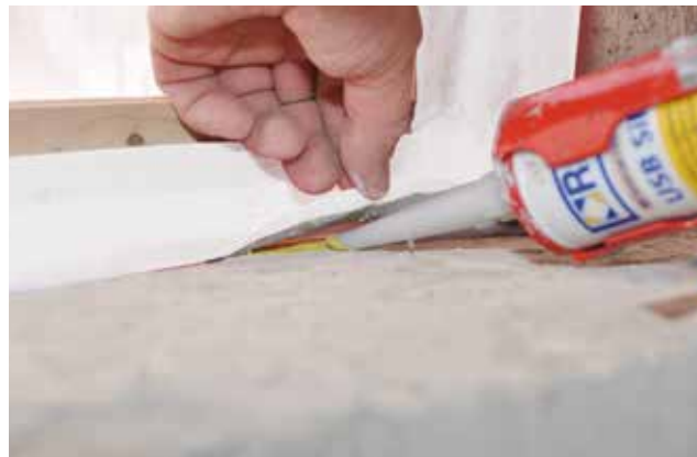
Incollaggio del nastro esterno FDB EXT AC su muratura.
