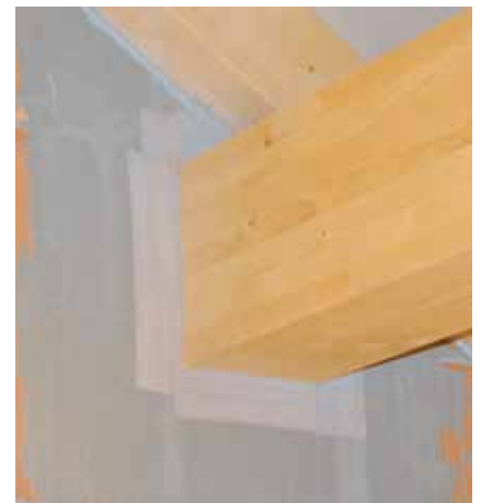
Sigillatura con il nastro intonacabile AIR Coll 75 X tra trave in legno e murature
