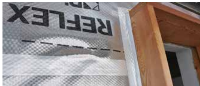
Sigillatura della membrana traspirante USB Reflex Plus sulle finestre
