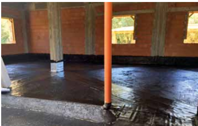
Preparazione della superficie con USB Primer BIT
