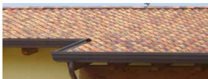
Posa delle tegole con i ganci per l'ancoraggio
