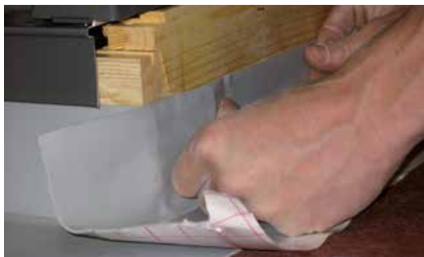
5. Posa del nastro USB Coll 150 X sul lato alto della finestra
