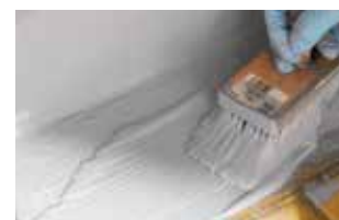
Seconda mano di USB Tape LIQUID
