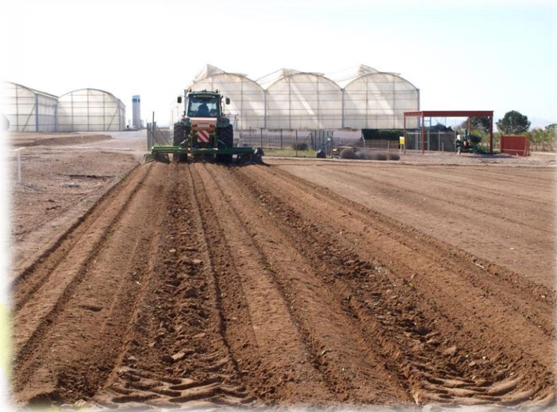
Imagen nº3 Corte de tierra
