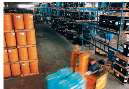
... hasta almacenes de productos químicos y petroquímicos, generadores y muchos otros.
