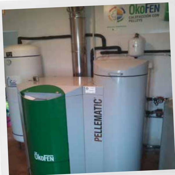
PE32B (32 kW) año 2013 Portugal „Sustitución por caldera de gasoil“
