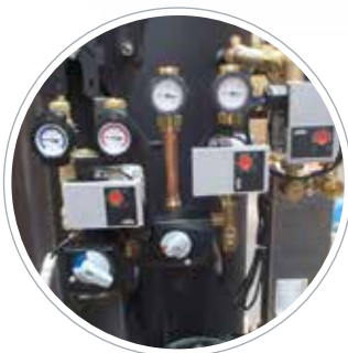
Circuitos de calefacción
