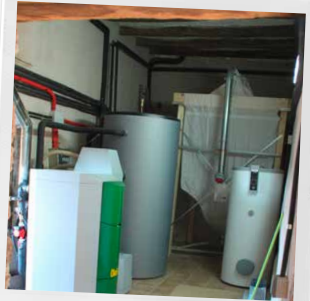
PES56 (56 kW) año 2011 Barcelona „Silo de pellets con altura especial“
