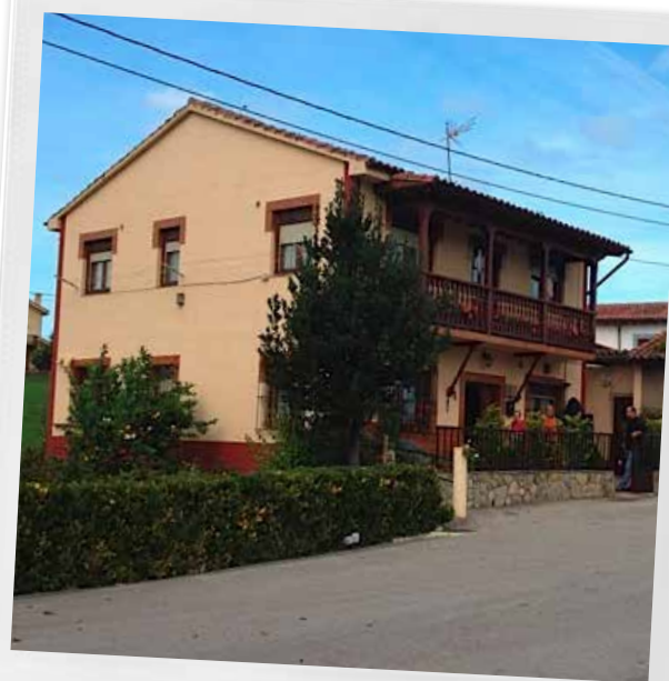
PE20 (20 kW) año 2012 Cantabria „Sustitución por caldera de gasoil“
