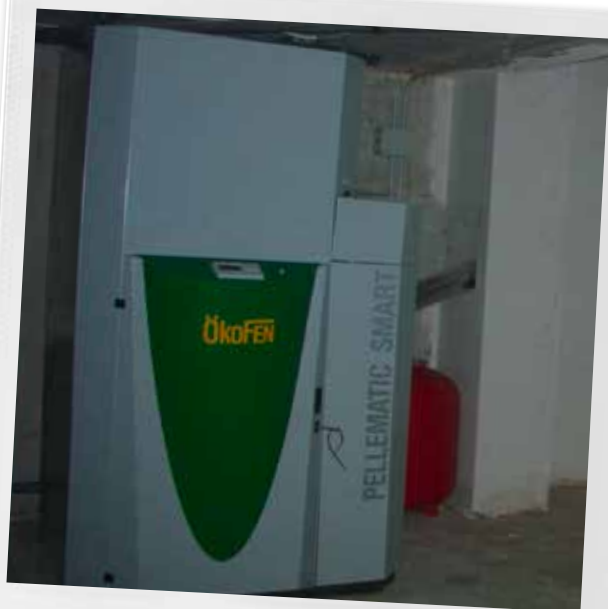
Smart8 (8 kW) año 2012 Asturias „Vivienda nueva“
