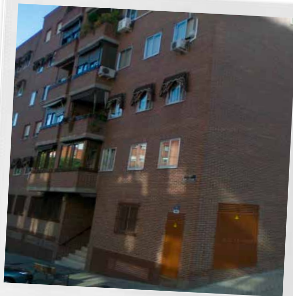
3 PETS224 (12x56 kW) año 2012 Madrid „Sustitución por calderas de gasoil“
