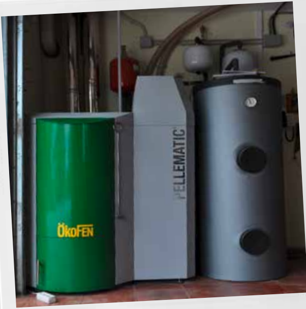
PES20 (20 kW) año 2012 Burgos „Sustitución por caldera de gasoil“
