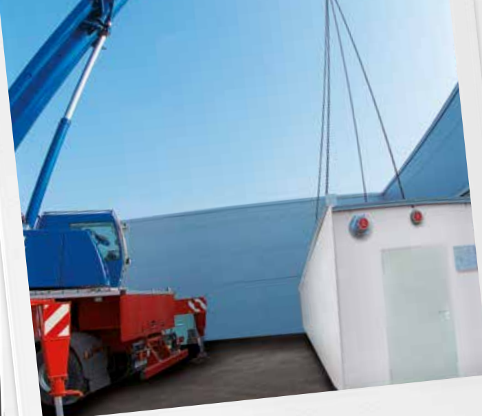
La instalación de calefacción en el exterior
