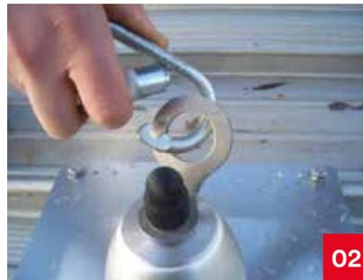
Conecte el mosquetón y el sistema de protección contra caídas (p. ej., una eslinga de absorbedor de energía) al anclaje mediante la anilla de conexión. Asegúrese de que el mosquetón está bloqueado y ajustado.
