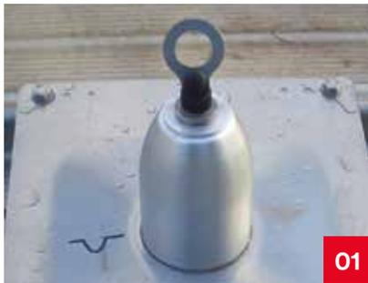
Examine el anclaje para asegurarse de que está ajustado y la anilla de acoplamiento no tiene obstáculos a la hora de girar.
