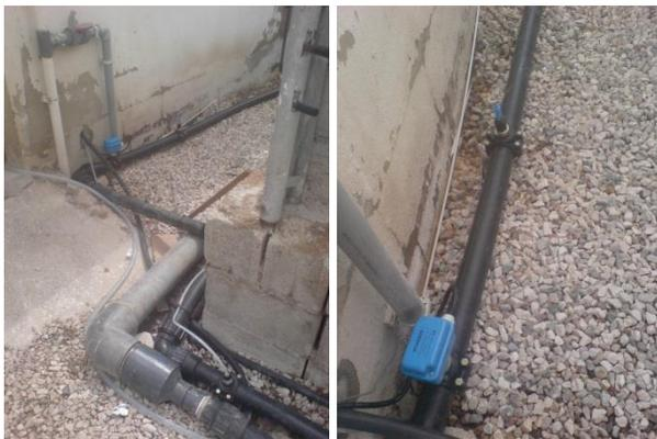
Instalación de inyección en un punto entre el embalse A y B, realizándose la inyección a unos 60 m antes. Esta inyección solo se activa en el llenado del embalse A según demanda y se consigue con el, que el agua de procedencia del embalse B, llegue al embalse A, con una mínima carga de materia orgánica. Apto seguido y realizada la parada de llenado, se activa el sistema de recirculación donde se sigue con el tratamiento en recirculación.
