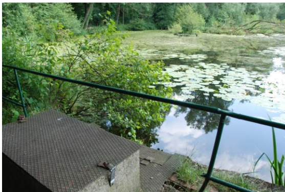
Abb.4: Mühlenteich mit Überlauf/Ablauf Georgsmarienhütte 17.07.2014
