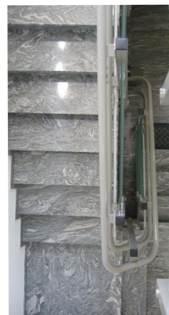
Escalera con rampas múltiples
