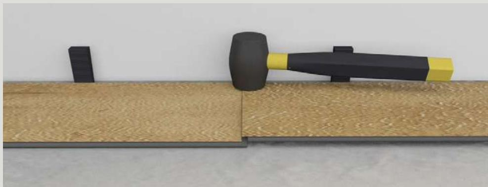
Use el martillo de goma para golpear justo encima de las juntas de las tablas y encajarlas perfectamente. ATENCIÓN: un golpe sobre la junta incorrectamente alineada podría dañar la articulación. / *Make sure that the planks fit together using of a mallet and a rubber block. ATTENTION: a blow to the incorrectly aligned joint could damage the edges.*
