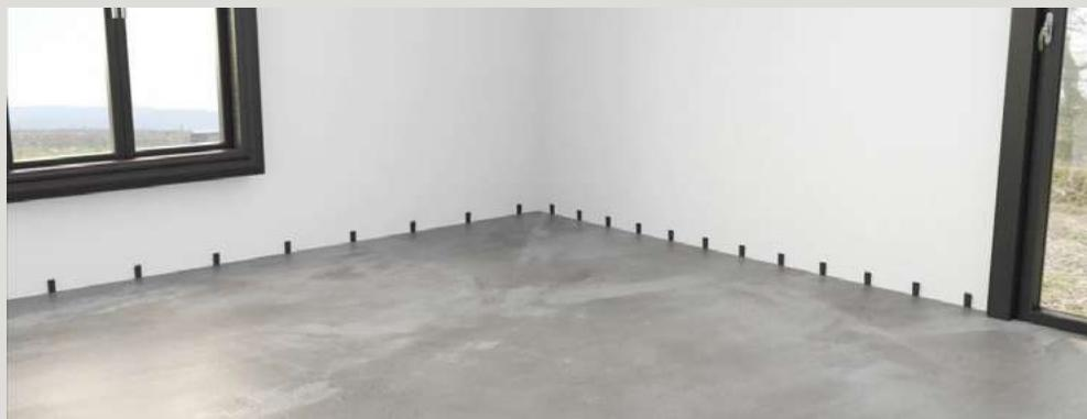
Use espaciadores de 6mm entre cualquier objeto fijo (paredes, armarios, etc.) y el producto. En cuartos de baño, dejar 10 mm de separación y rellenar con un sellante de silicona. / *Use 6 mm. spacers between any fixed object (wall, cabinets, etc...) and the product. In bathrooms, leave a space of 10 mm. between the object and fill it with a silicone sealant.*
