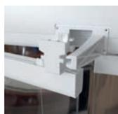
Sistema de apertura intermedia del primer panel que permite una ventilación controlada con un ángulo de apertura de 7,5°.
