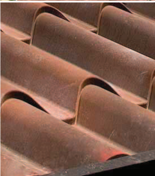
Detalle de la cubierta
