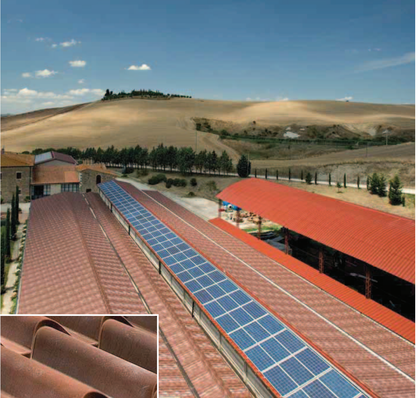
Rehabilitación de Granja en Pienza - Siena
