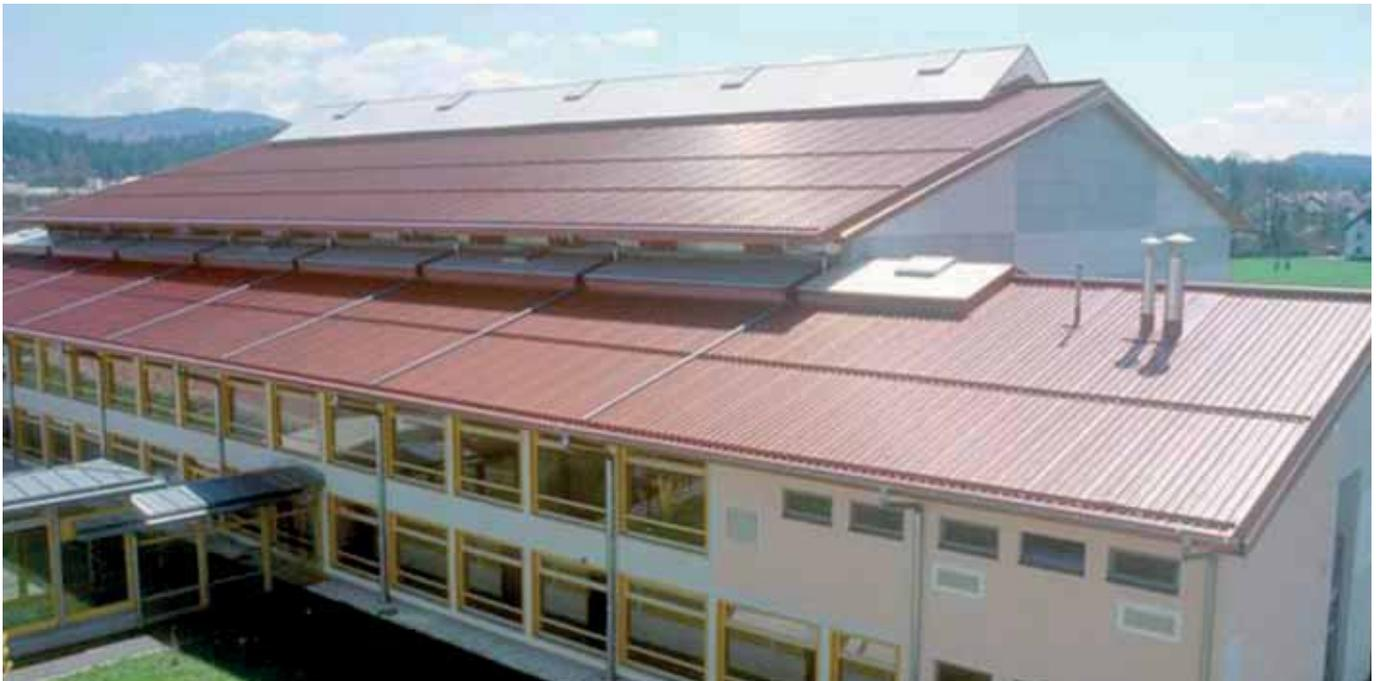
Panel sándwich mono lámina con prestaciones estéticas limitadas, para cubiertas con pendiente no inferior al 7%, aislado en poliuretano, con lámina exterior perfilada de 5 greclas para aumentar la resistencia a las cargas estáticas y dinámicas. La fijación es a vista con grapas. El soporte interior es de aluminio centesimal gofrado.
