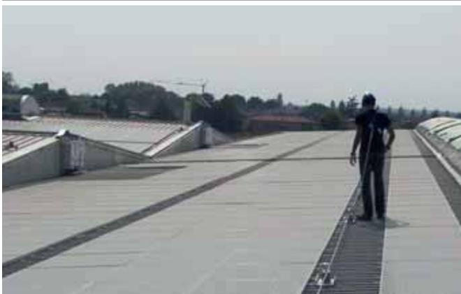
El sistema ISOPANSAFE BASE es un sistema de fijación a vertiente, su utilización está vinculado por la presencia de cubiertas realizadas con paneles ISOCOP-5 1000 o ISODOMUS; están disponibles 3 tipologías de fijación, respectivamente a la subestructura, a la superestructura o híbrido.
