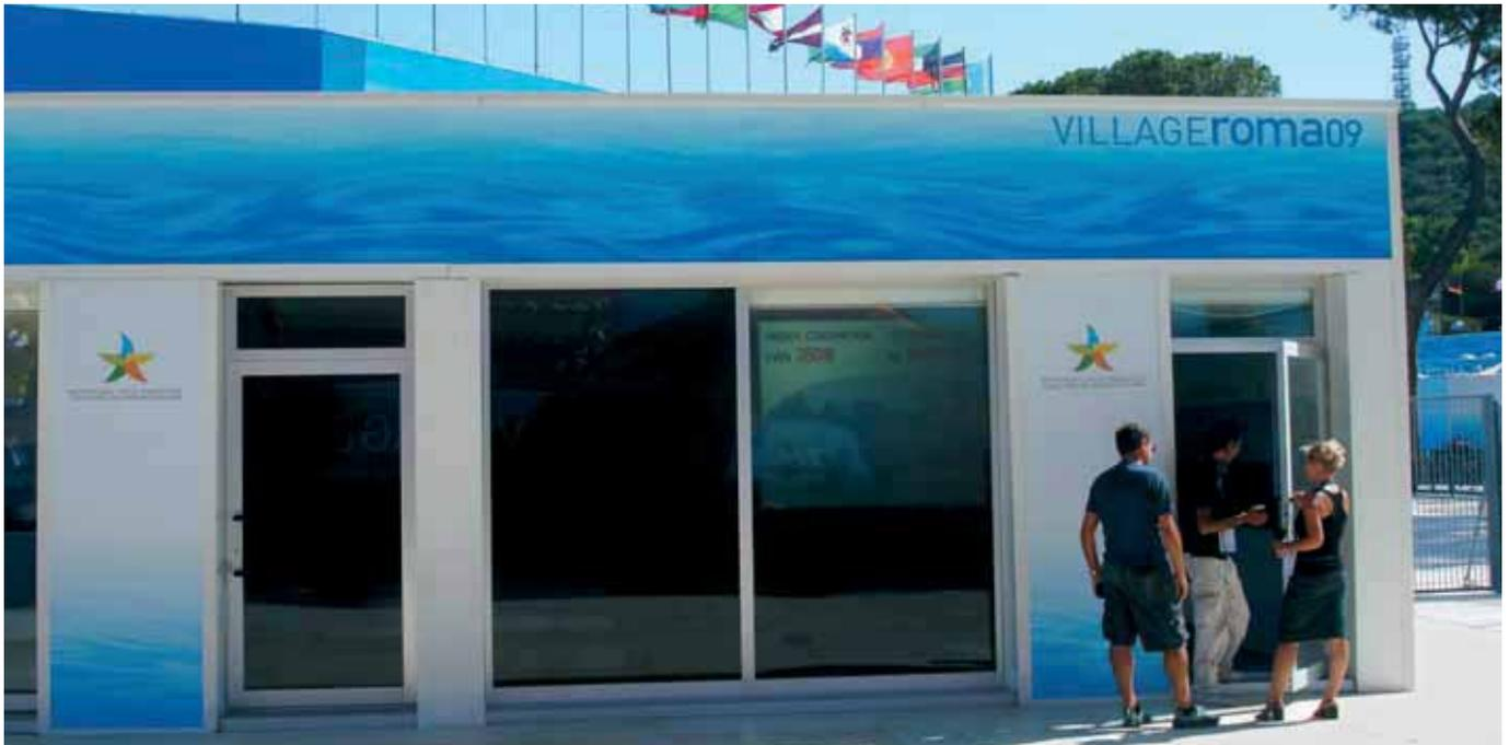
Panel de fachada de doble revestimiento metálico con aislamiento en poliuretano. La junta, con encastre machi-hembrado, es a vista, con tornillo pasante. Disponible en diferentes tipos de perfilado.
