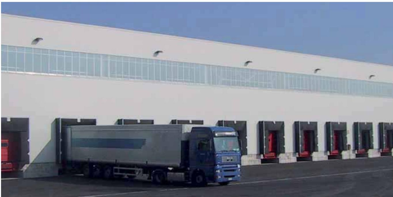
Panel de fachada de doble revestimiento metálico con aislamiento en lana mineral. La junta, con encastramiento machi-hembrado, es a vista, con tornillo pasante.
