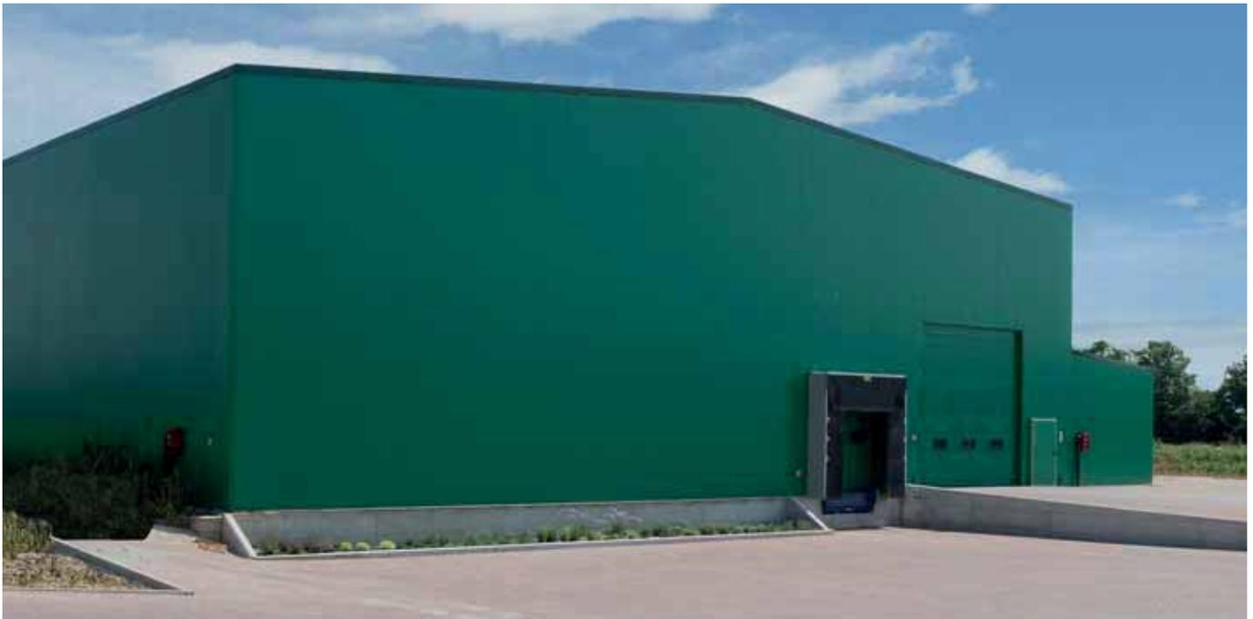
Panel de fachada de doble revestimiento metálico con aislamiento en poliuretano. La junta, con encastre machi-hembrado, es vista, con tornillo pasante. Disponible en diferentes tipos de perfilado.
