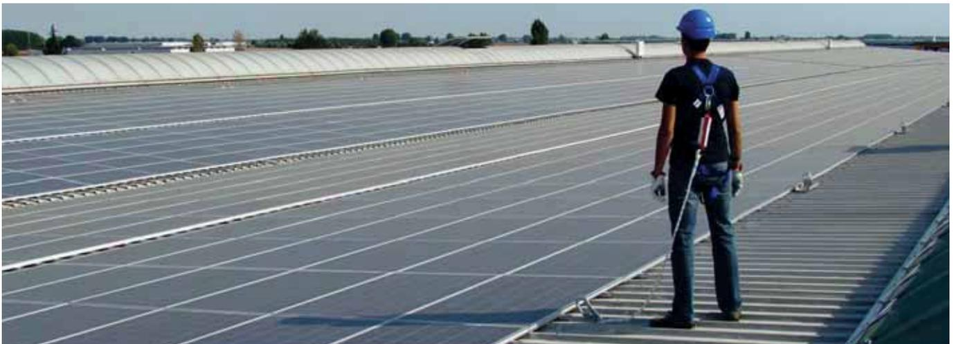
Los sistemas anticaída ISOPANSAFE nacen para garantizar la seguridad de los trabajadores en altura sobre las cubiertas y para permitir máxima libertad de movimiento en fase de intervención: los dispositivos realizados están marcados CE y certificados según la norma EN 765 2012.
