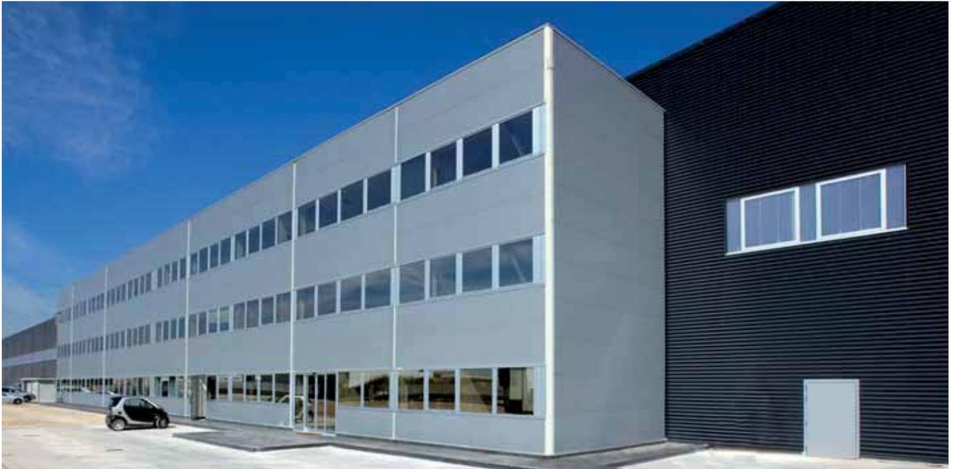
Panel de fachada de doble revestimiento metálico con aislamiento en poliuretano, de perfil exterior ondulado. La junta, con encastre machi-hembrado, es oculta, con tornillo pasante. Se puede utilizar conjuntamente con el panel Isoparete Plissé y Isoparete Piano.
