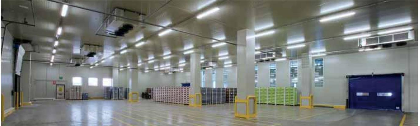
Panel metálico autoportante; aislante con poliuretano expandido, de gran versatilidad y facilidad de montaje. Las elevadísimas prestaciones de aislamiento térmico y a la calidad del sistema de unión, lo hacen especialmente adecuado para la realización de ambientes en los que se exija una temperatura controlada.
