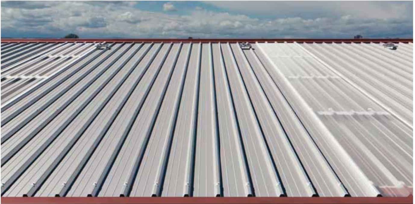
Panel sándwich de doble revestimiento metálico, para cubiertas con pendiente no inferior al 7%, aislado en poliuretano, con lámina exterior perfilada de 5 greclas para aumentar la resistencia a las cargas estáticas y dinámicas. La fijación es vista con grapas metálicas con guarnición. Se usa también para recubrir fachadas.
