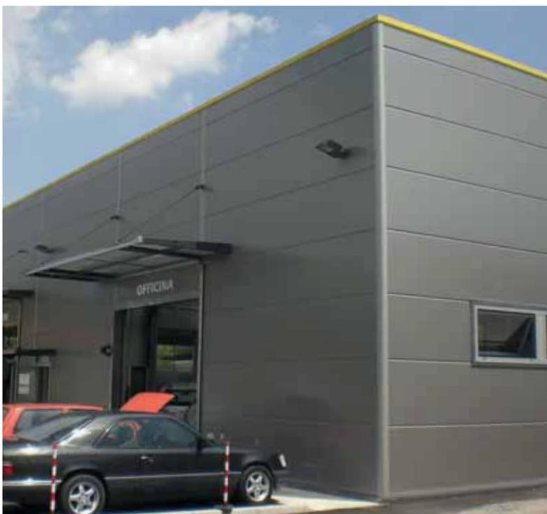
Los sistemas R.A.C. (Racor Angular Aislado) son elementos de acabado angulares estudiados particularmente para fachadas realizadas con paneles sandwich Isopan. Los Racores Angulares Aislados se producen según croquis y según de las necesidades de la obra; de esta forma se consigue utilizar un acabado práctico, elegante y hecho a medida para el proyecto.
