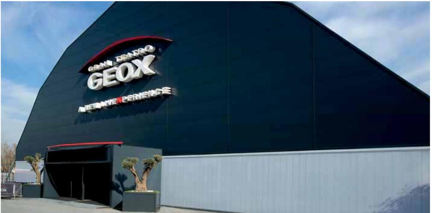
Panel de fachada de doble revestimiento metálico con aislamiento en poliuretano. La junta, con encastre machi-hembrado, es oculta, con tornillo pasante. Disponible en diferentes tipos de perfilado. Se puede utilizar conjuntamente con el panel Isoclass.
