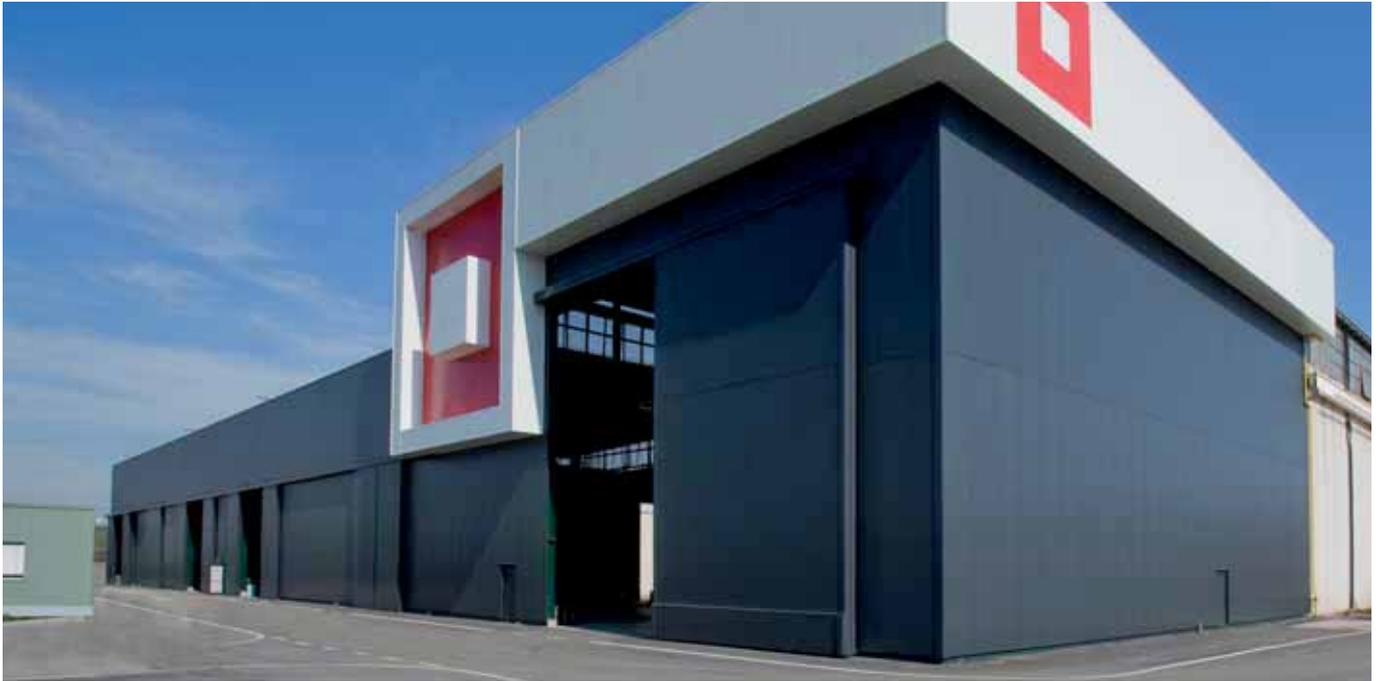
Panel de fachada de doble revestimiento metálico con aislamiento en lana mineral. La junta, con encastre machi-hembrado, es oculta, con tornillo pasante. Disponible en diferentes tipos de perfilado.
