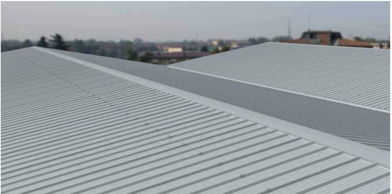
Panel sándwich de doble revestimiento metálico, para cubiertas con pendiente no inferior al 7%, aislado en poliuretano, con lámina exterior perfilada de 5 greclas. La fijación es vista con grapas tapajuntas de encastre.
