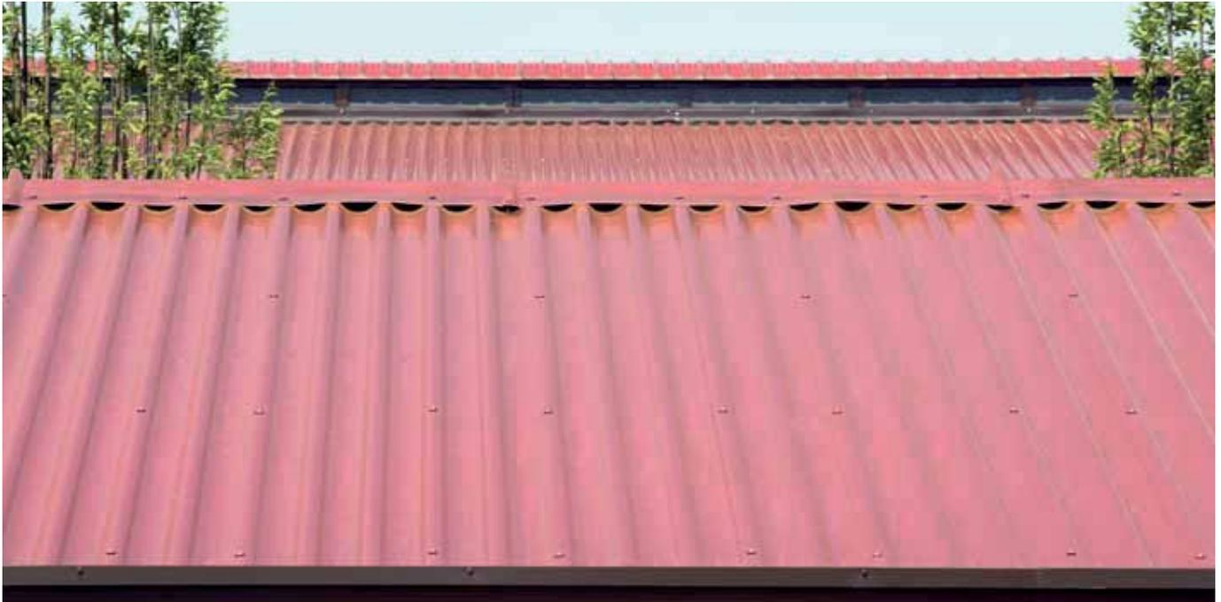
Panel sándwich de doble revestimiento metálico, para cubiertas con pendiente no inferior al 7%, aislado en poliuretano, con lámina exterior perfilada de 6 ondas. La fijación es vista con grapas y guarniciones.
