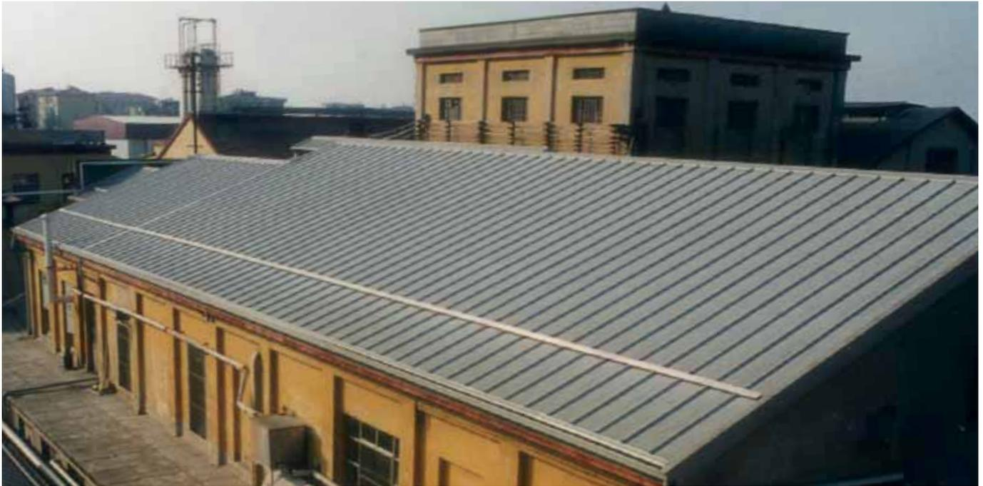
Panel sándwich de doble revestimiento metálico, para cubiertas con pendiente no inferior al 7%, aislado en poliuretano, con lámina exterior perfilada de 3 grecas. La fijación es vista con grapas y guarniciones.
