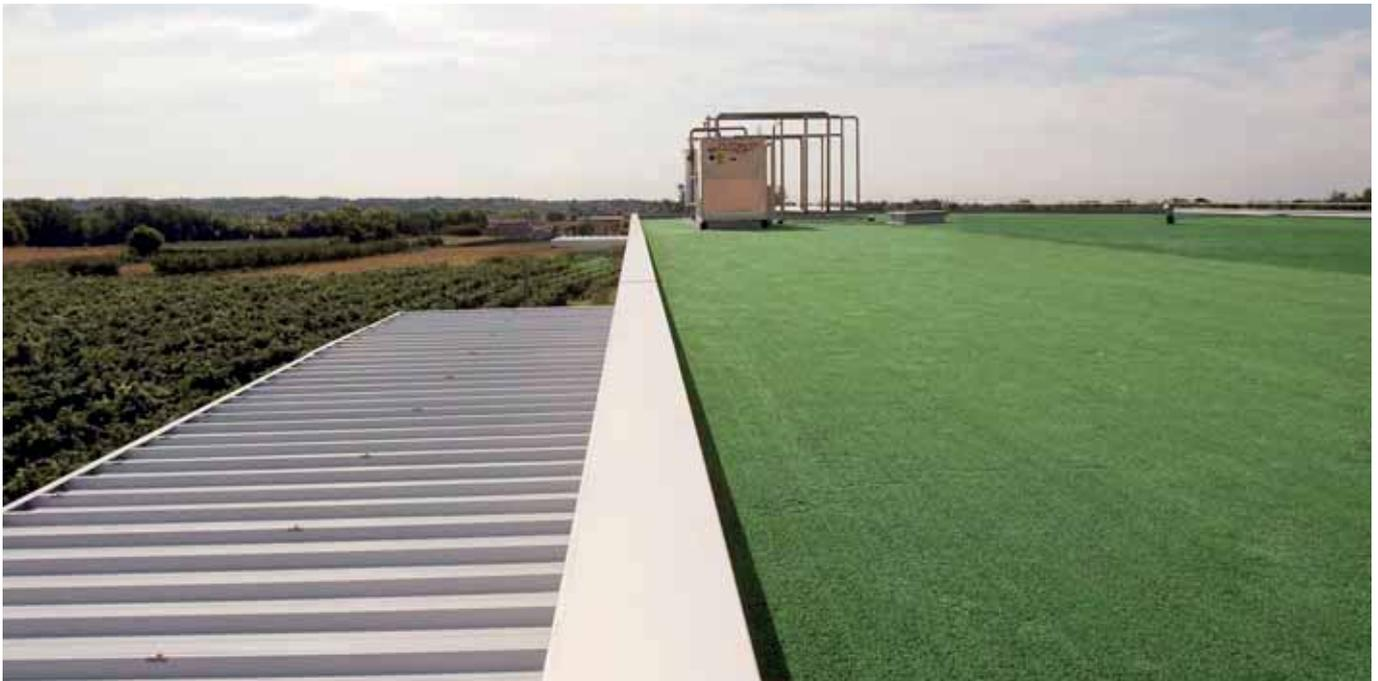
Panel sándwich mono lámina, para cubiertas con pendiente no inferior al 7%, aislado en poliuretano, con lámina exterior perfilada de 5 greclas para aumentar la resistencia a las cargas estáticas y dinámicas. La fijación es a vista con grapas y guarniciones. Se puede utilizar para montar cubiertas planas, gracias al soporte en cartón bituminoso.
