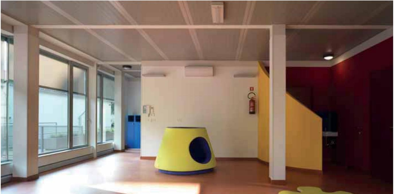
Panel sándwich de doble revestimiento metálico, para cubiertas con pendiente no inferior al 7%, aislamiento en lana mineral, con lámina exterior perfiladas de 5 greclas para aumentar la resistencia a las cargas estáticas y dinámicas. La fijación es vista con grapas metálicas con guarnición. El soporte interior es de lámina micro perforada que permite aumentar las prestaciones de absorción acústica del panel.
