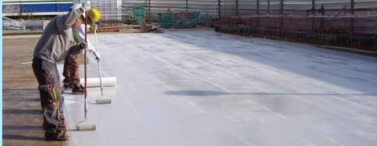
Membrana de poliuretano monocomponente impermeable de aplicación líquida, altamente elástica, de aplicación y secado en frío.
