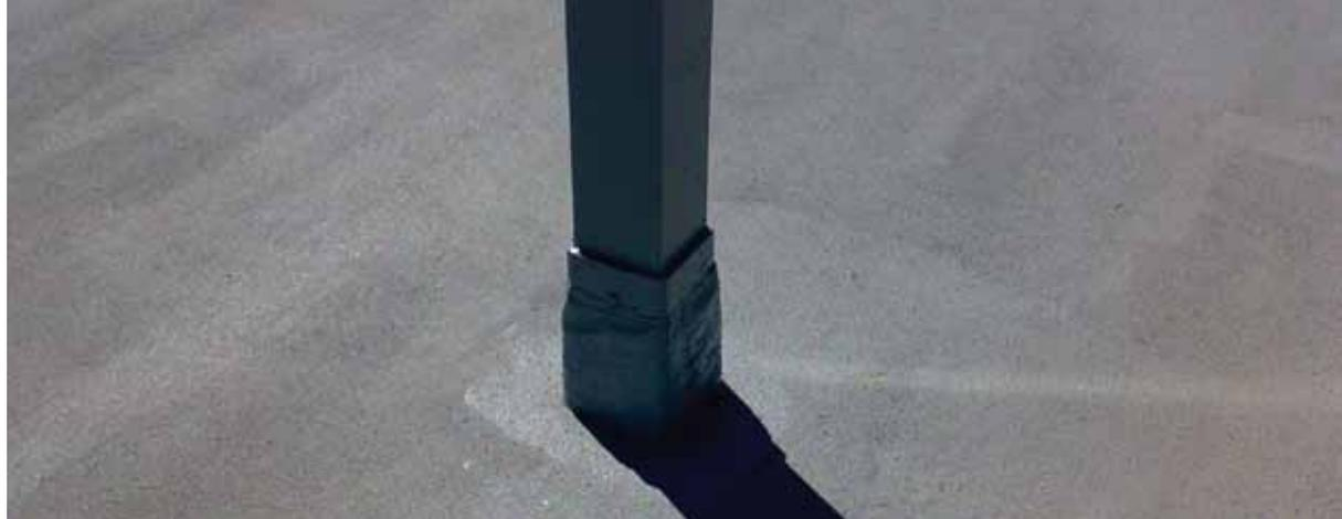
Membrana de poliuretano monocomponente impermeable reforzada con fibras, de aplicación líquida y secado en frío
