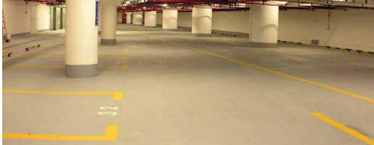
Mortero epoxídico tricomponente de base agua autonivelante.
