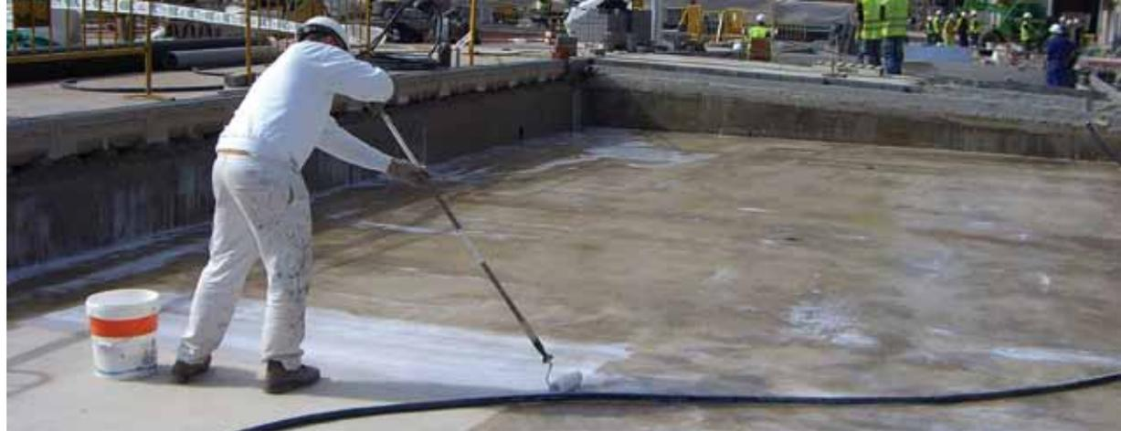
Imprimación epoxy bicomponente 100% sólidos para pavimentos de soportes húmedos
