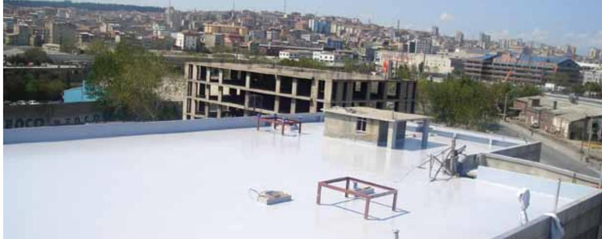
Membrana altamente elástica de poliuretano monocomponente base agua de aplicación líquida y secado en frío.
