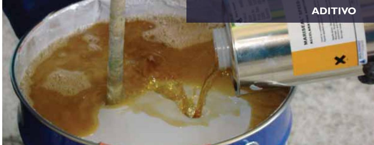
Aditivo acelerante de secado para membranas Mariseal
