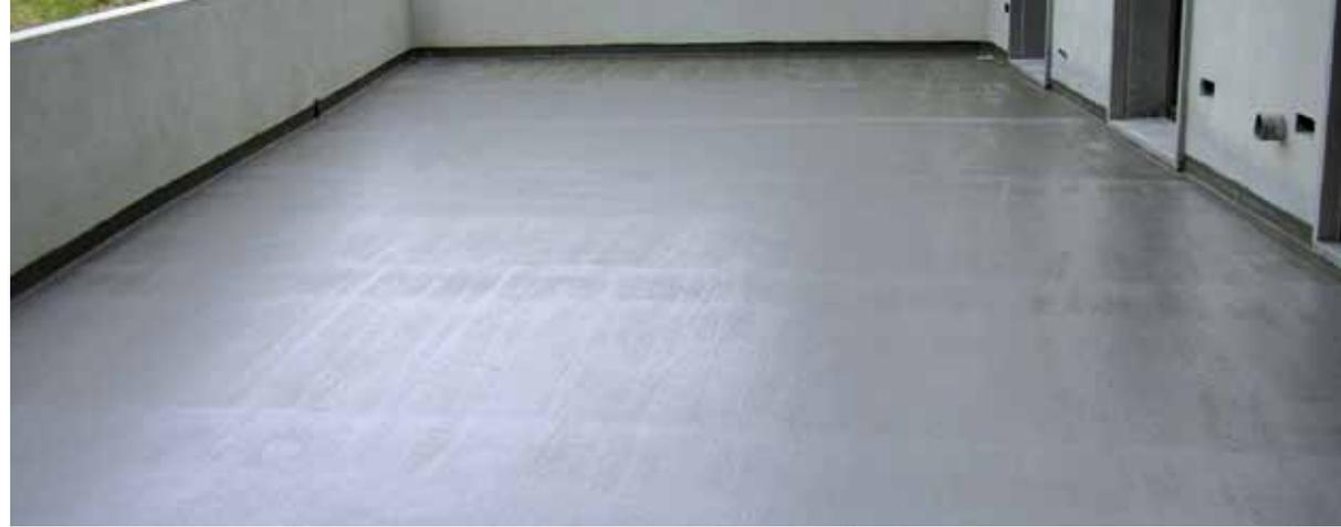
Mortero monocomponente impermeabilizante
