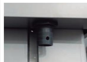
El tejado incorpora un record de desagüe dónde poder conectar un tubo para el aprovechamiento del agua de lluvia hacia un depósito.
