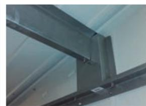
Viga con un raíl galvanizado y travesaños de metal que proporciona soporte al tejado y una mayor resistencia de construcción.
